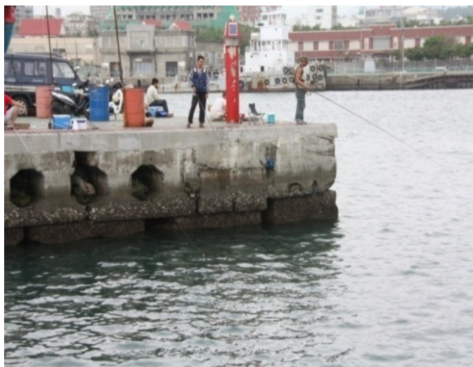
圖 5.9 花蓮港孔洞型碼頭岸壁
