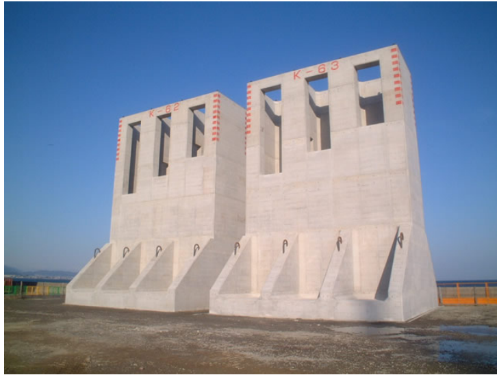
圖 5.16 生態系統之沉箱防波堤
