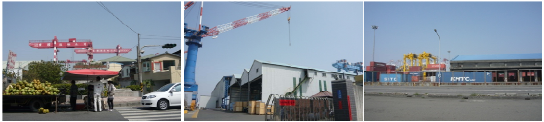
一般作業區 1_B 區 現況照片
