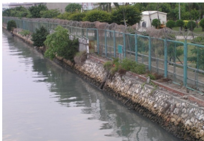
圖 5.12 高雄港第五號船渠之漿砌護岸
