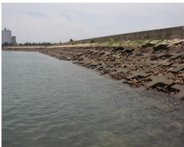
圖 5.10 臺中港緩坡護岸
