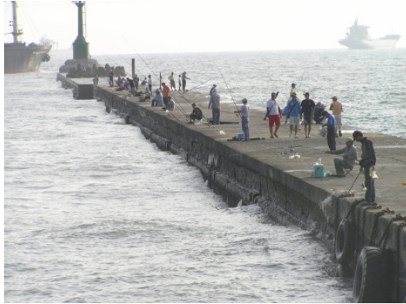
圖 5.4 高雄港沉箱防波堤
