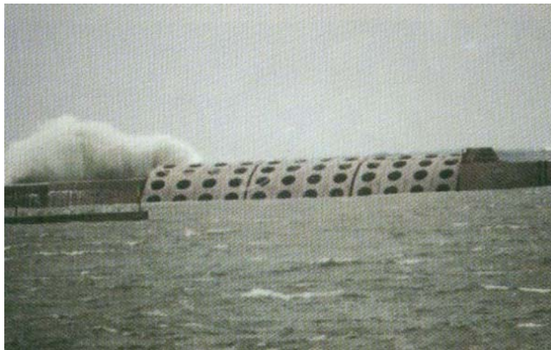
圖 5.15 開孔式新型防波堤
