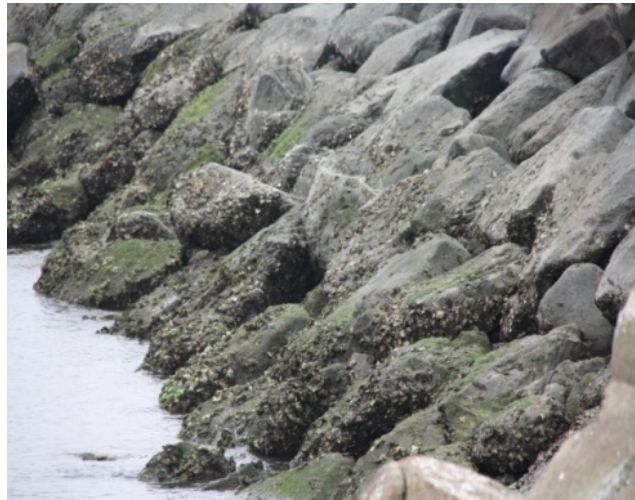
圖 5.11 臺北港區內之拋石護岸
