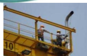
安裝採樣設備
