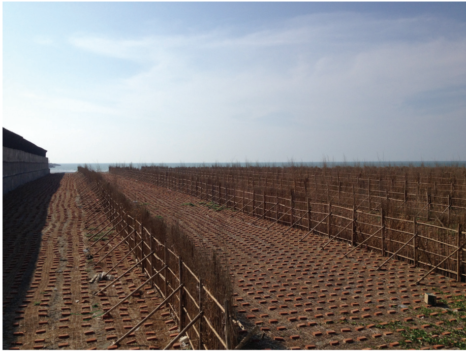
照片 2-4 北淤沙區三期整治區位置 1 現況 (2012/09)
