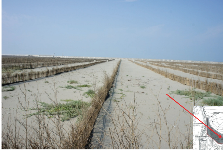
北淤沙區整治後邊釐定沙區現況b (2011/10)
