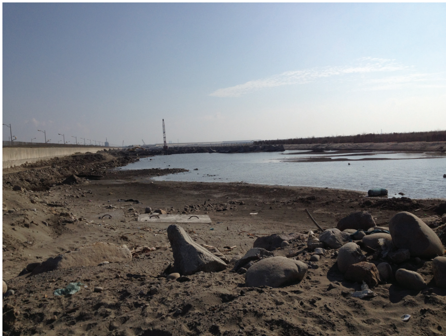
照片 2-6 北淤沙區三期整治區位置 3 現況 (2012/09)
