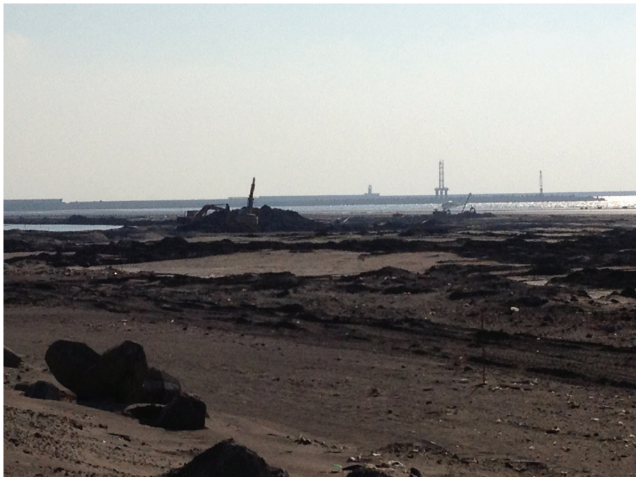
照片 2-9 北淤沙區三期整治區位置 6 現況 (2012/09)
