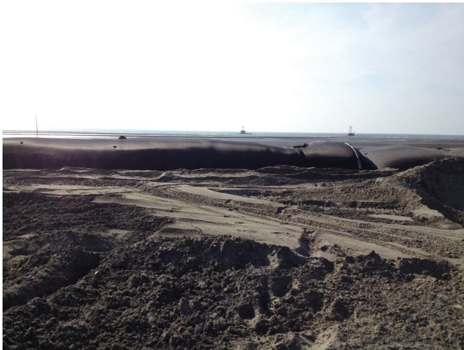
照片 2-8 北淤沙區三期整治區位置 5 現況 (2012/09)
