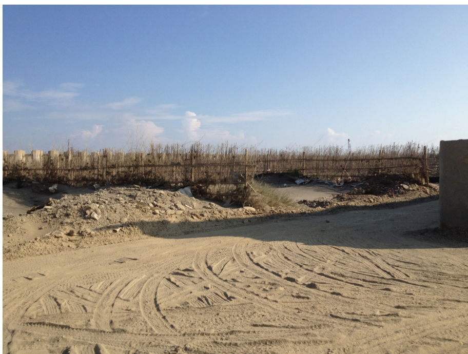
照片 2-10 北淤沙區三期整治區位置 7 現況 (2012/09)
