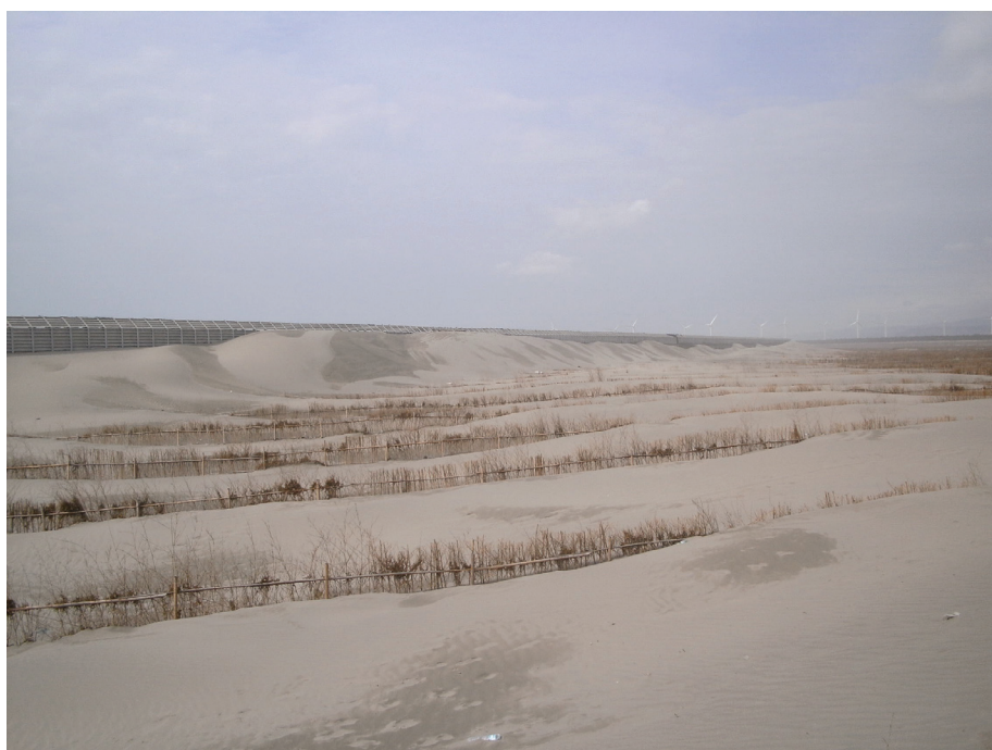
照片 2-11 北淤沙區三期整治區位置 8 現況 (2012/06)
