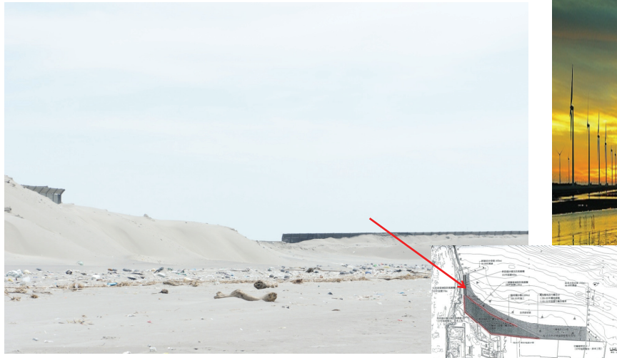
北北淤沙區防風柵欄外側及擋沙牆內側現況 (2012/06)
