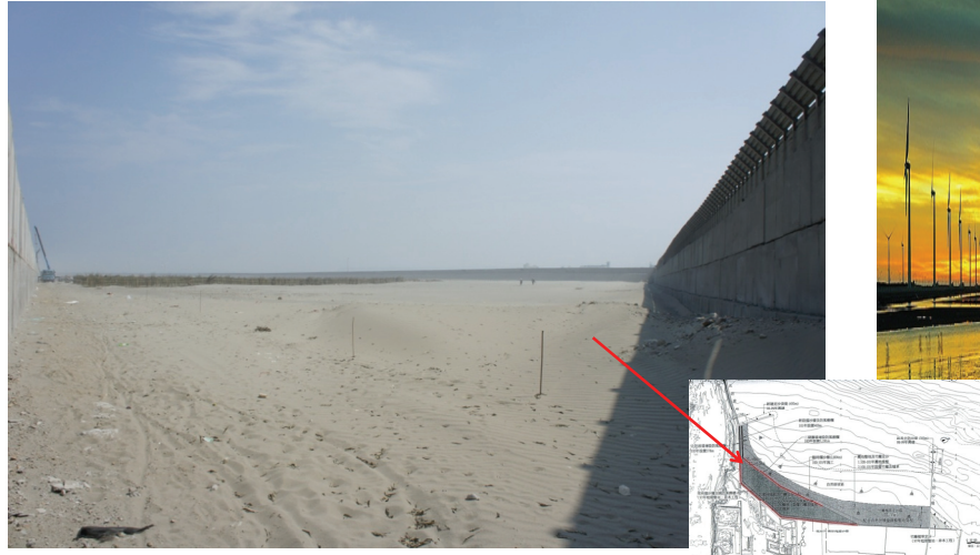
北淤沙區防風柵欄內與北防波堤堤址處現況 (2011/10)
