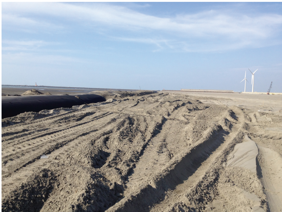
照片 2-7 北淤沙區三期整治區位置 4 現況 (2012/09)
