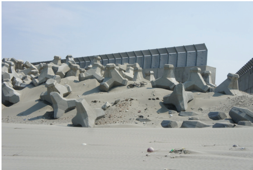
照片 2-2 第三期工程於圍堤堤頂處設置長防風柵欄 (2011/10)
