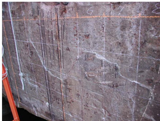
圖 2.20 測點方格繪製於碼頭岸壁面
