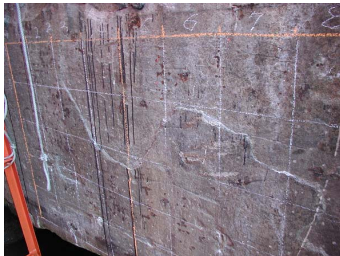
圖 4.1 碼頭岸壁面繪製方格
