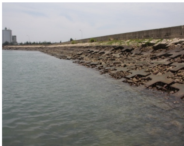
圖 5.10 台中港緩坡護岸
