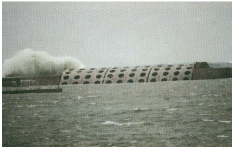
圖 5.15 開孔式新型防波堤
