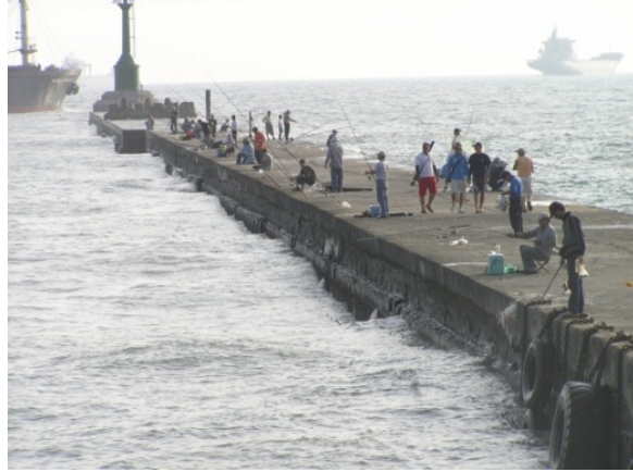
圖 5.4 高雄港沉箱防波堤
