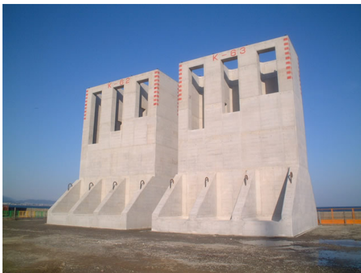
圖 5.16 生態系統之沉箱防波堤
