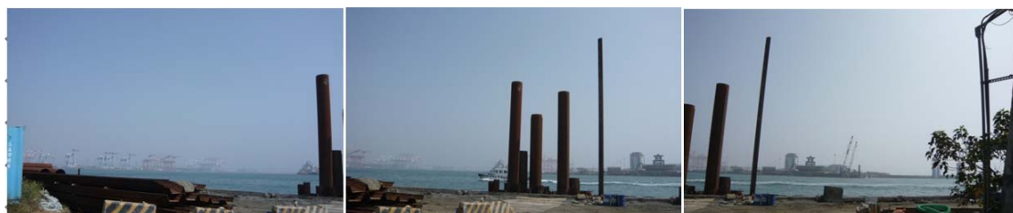
一般作業區 1_A 區 現況照片
