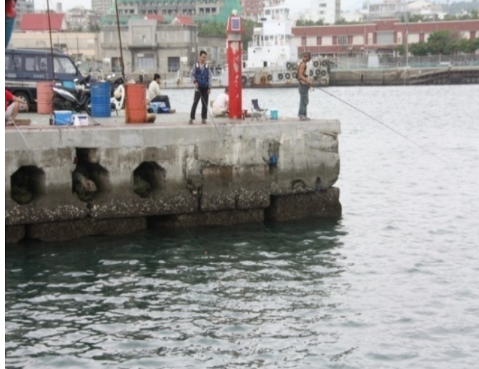
圖 5.9 花蓮港孔洞型碼頭岸壁
