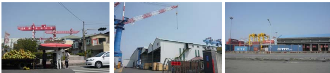
一般作業區 1_B 區 現況照片
