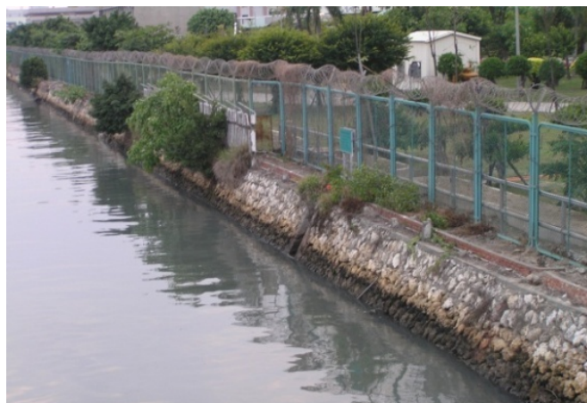
圖 5.12 高雄港第五號船渠之漿砌護岸
