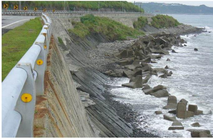
圖 5.3.13 海岸公路前消波塊及護岸混凝土剝落毀損
