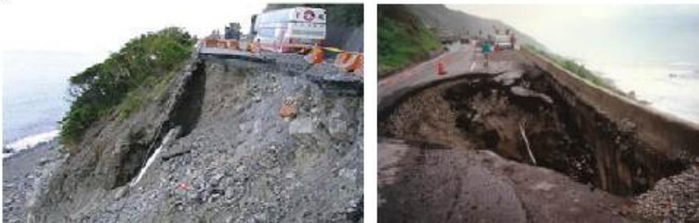
圖 5.3.10 坡面滑動及下陷流失造成破壞情形
