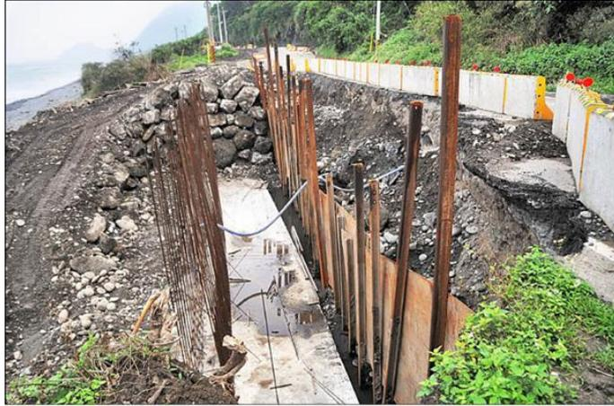
圖 5.3.15 海岸公路邊坡護岸被波浪淘空崩塌(取自自由時報,2009)
