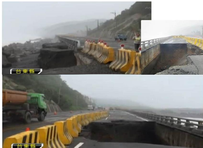
圖 5.3.5 臺 9 線南迴段道路遭大浪破壞情形(聯合新聞網)
