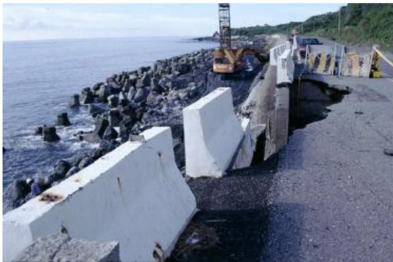
圖 5.3.1 海岸公路嘉平段路面塌陷情形
