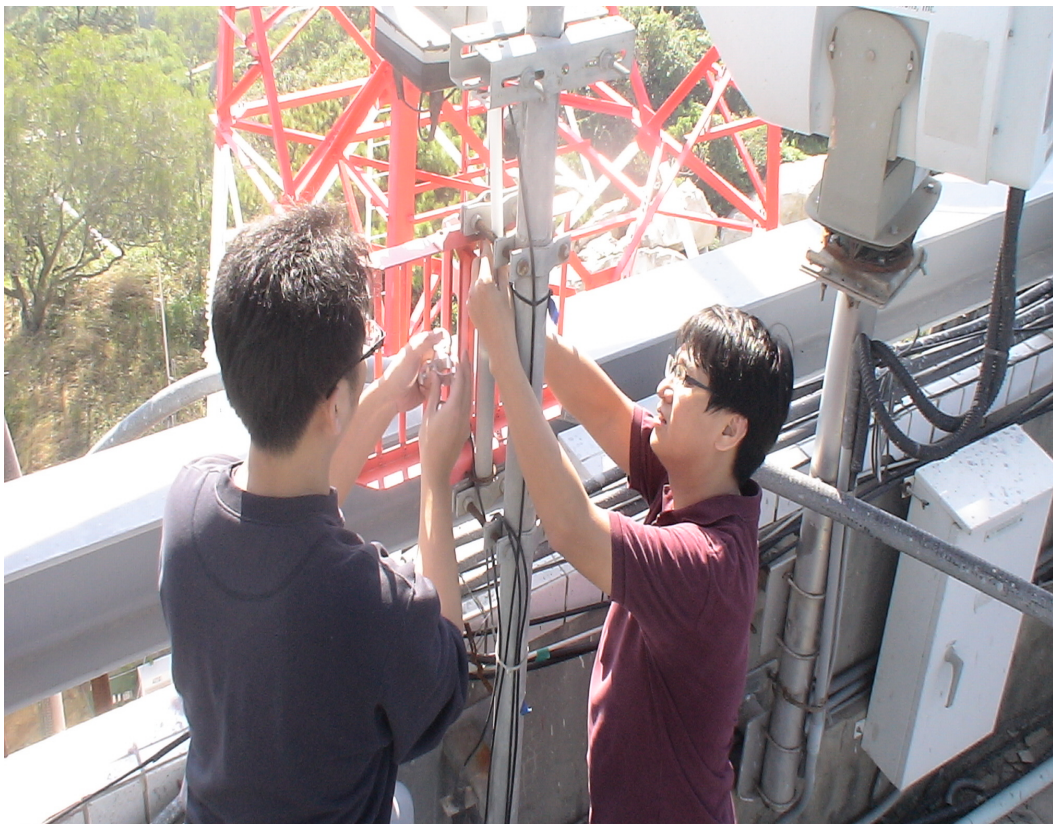
圖 8.7 金門大武山接收站 AIS 天線安裝(西元 2011 年 12 月)
