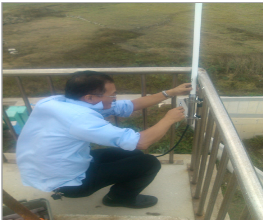
圖 8.19 澎湖吉貝嶼接收站 AIS 天線安裝(西元 2012 年 11 月)
