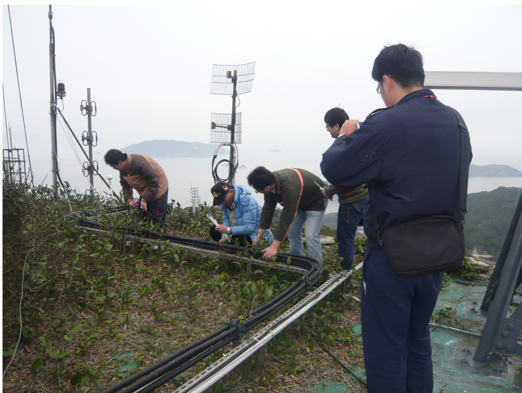
圖 8.11 馬祖北竿接收站 AIS 天線安裝(西元 2012 年 3 月)
