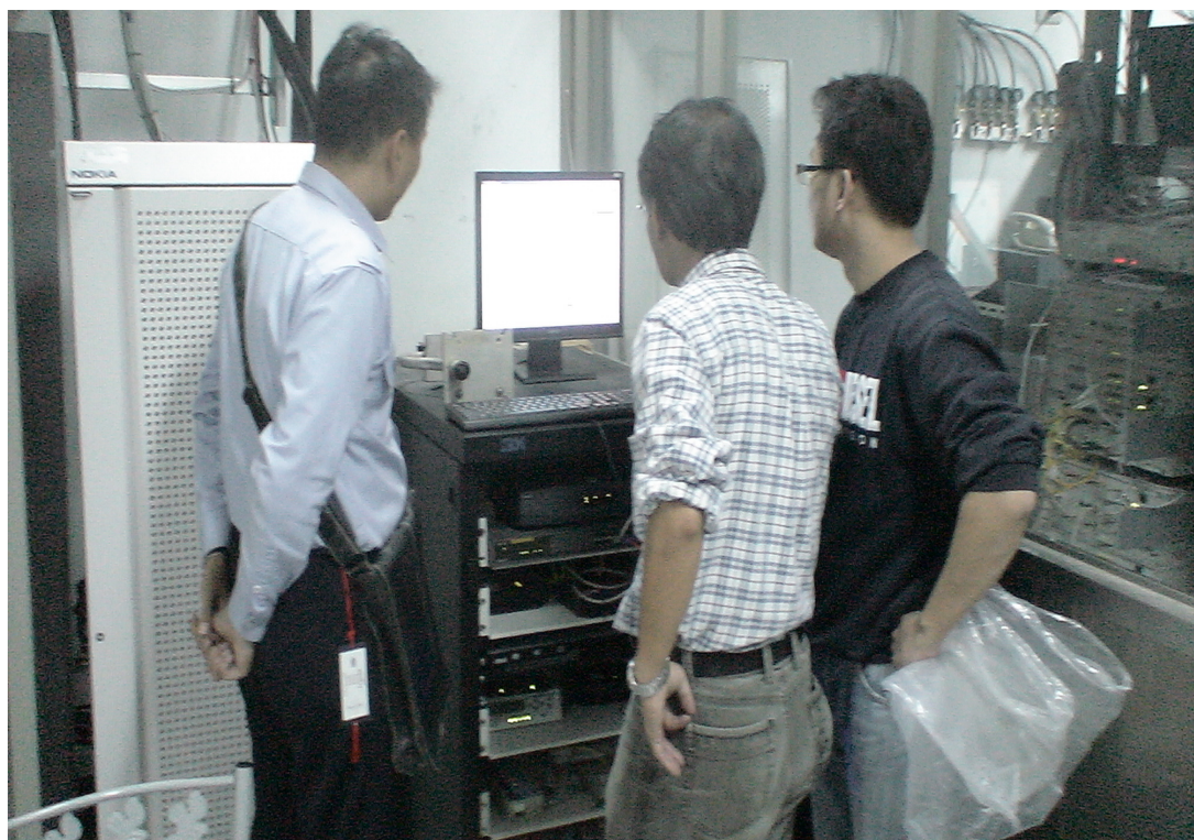
圖 8.9 金門大武山 AIS 設備裝設及連線測試(西元 2011 年 12 月)
