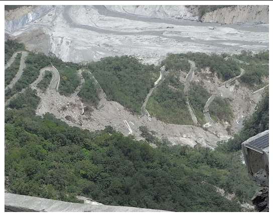
圖 7.64 台 24 線 46K+000 於莫拉 克颱風期間道路阻斷情形
