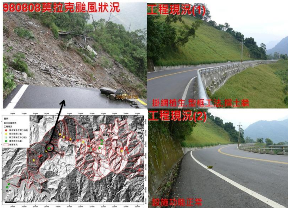
圖 7.79 樁號 28K+300 岩體滑動災害狀況與復建工程現況圖
