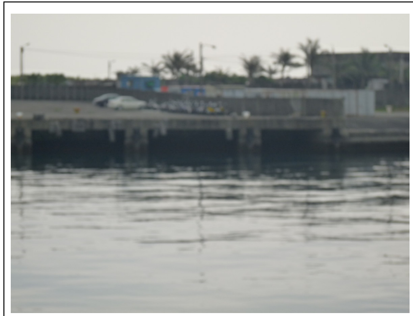
圖 3.32 花蓮港 15 號碼頭現況情形(101.3.26)
