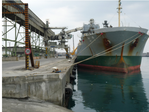
圖 3.29 花蓮港 13 號碼頭現況情形(101.3.26)
