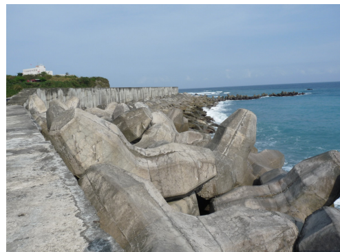
圖 3.73 長濱漁港防波堤及消波塊混凝土表面地圖狀裂縫 (101.3.29)
