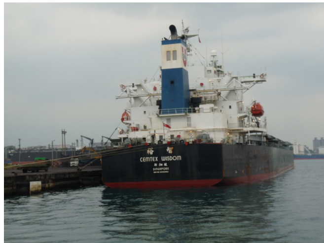
圖 3.46 花蓮港 25 號碼頭現況情形(101.3.27)
