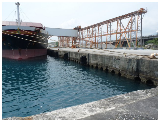
圖 3.35 花蓮港 17 號碼頭現況情形(101.3.27)
