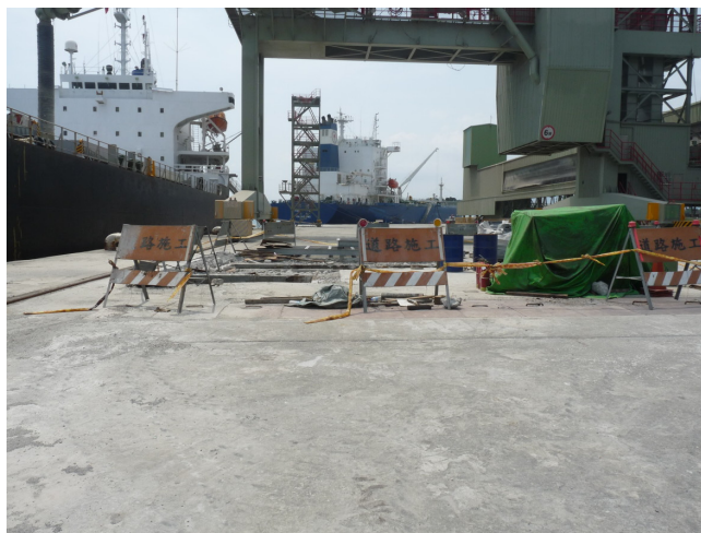
圖 3.38 花蓮港 19 號碼頭現況情形(101.3.27)
