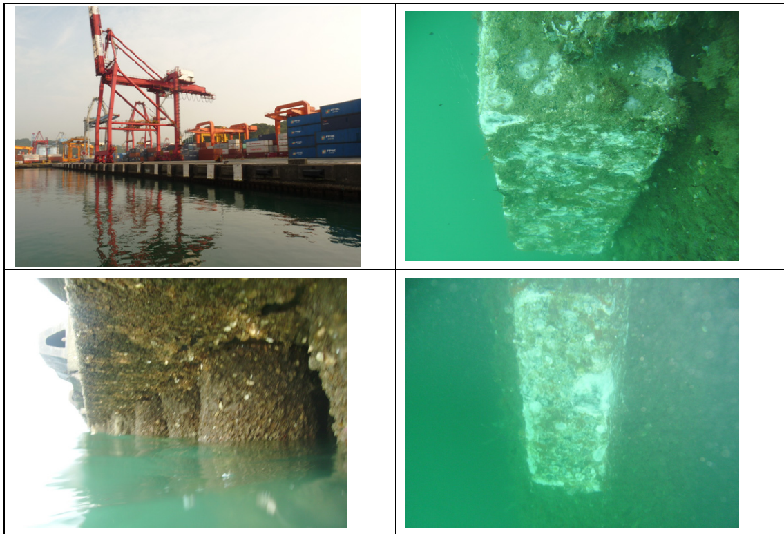
圖 3.110 基隆港西 20 號碼頭現況情形 (101.5.8)
