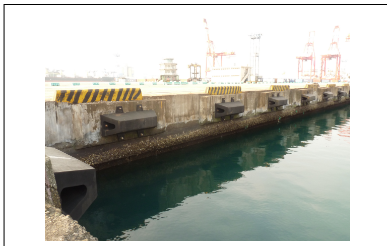
圖 3.118 基隆港西 23 號碼頭現況情形 (101.5.9)
