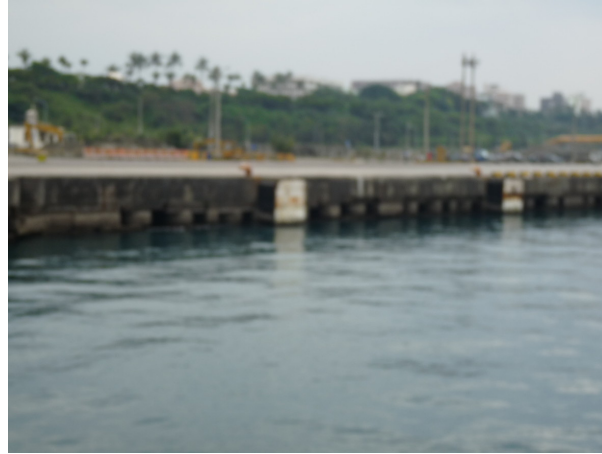
圖 3.40 花蓮港 21 號碼頭現況情形(101.3.27)
