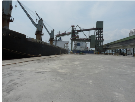
圖 3.39 花蓮港 20 號碼頭現況情形(101.3.27)
