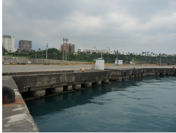
圖 3.41 花蓮港 22 號碼頭現況情形(101.3.27)
