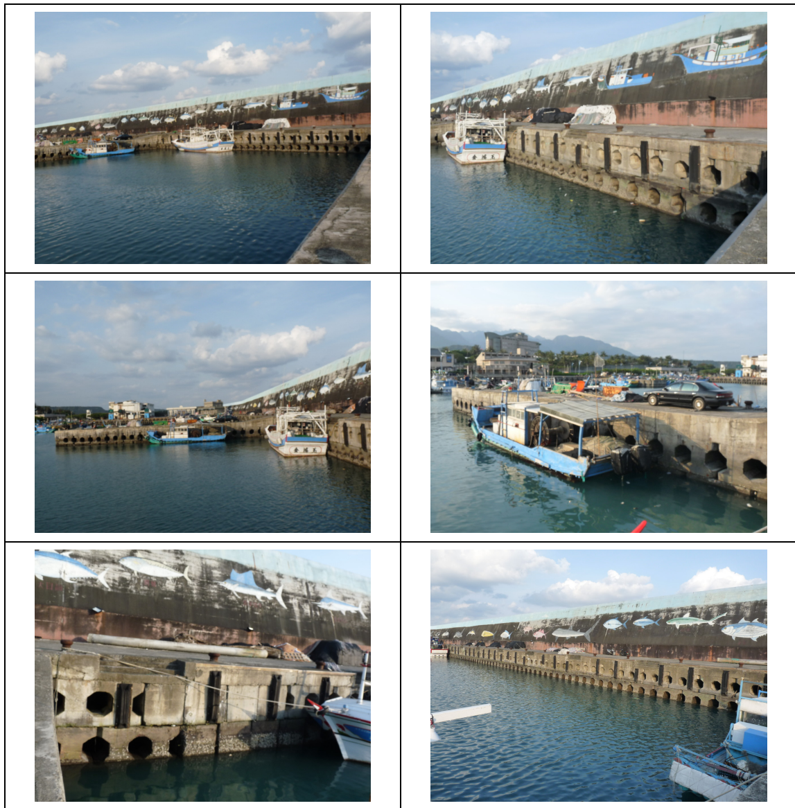
圖 3.86 新港漁港現況情形 (101.3.29)
