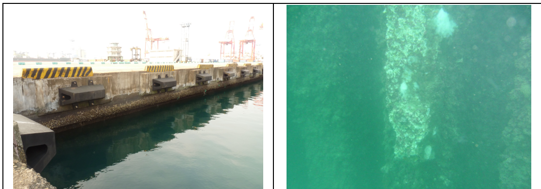
圖 3.116 基隆港西 22 號碼頭現況情形示 (101.5.9)
