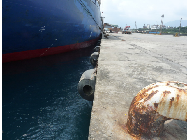
圖 3.44 花蓮港 24 號碼頭現況情形(101.3.27)
