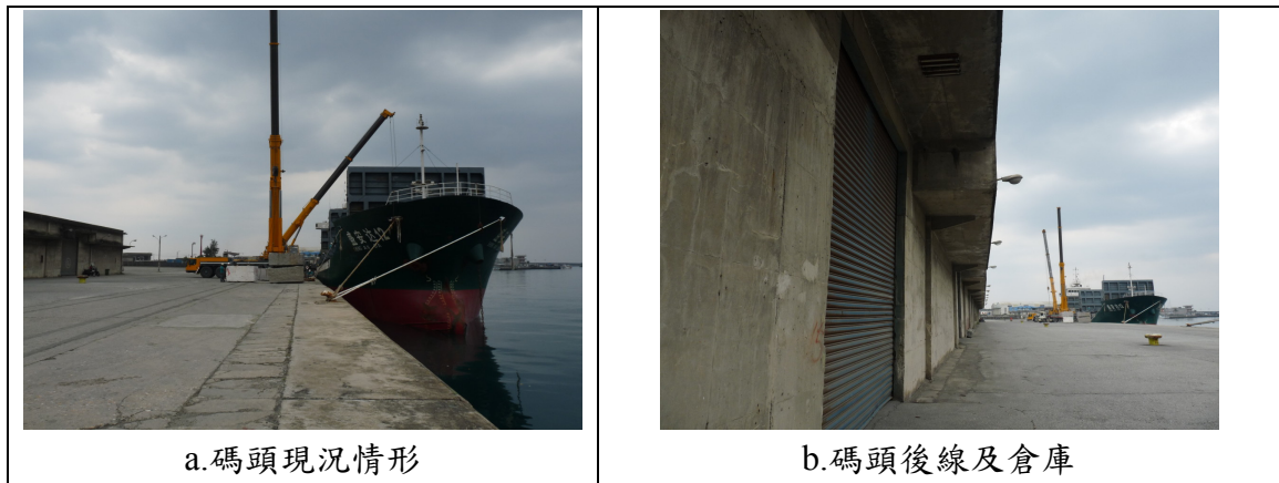
圖 3.30 花蓮港 14 號碼頭現況情形(101.3.26)
