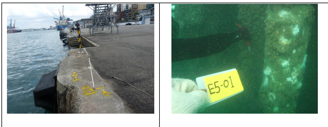
圖 3.123 基隆港東 5 號碼頭現況情形
