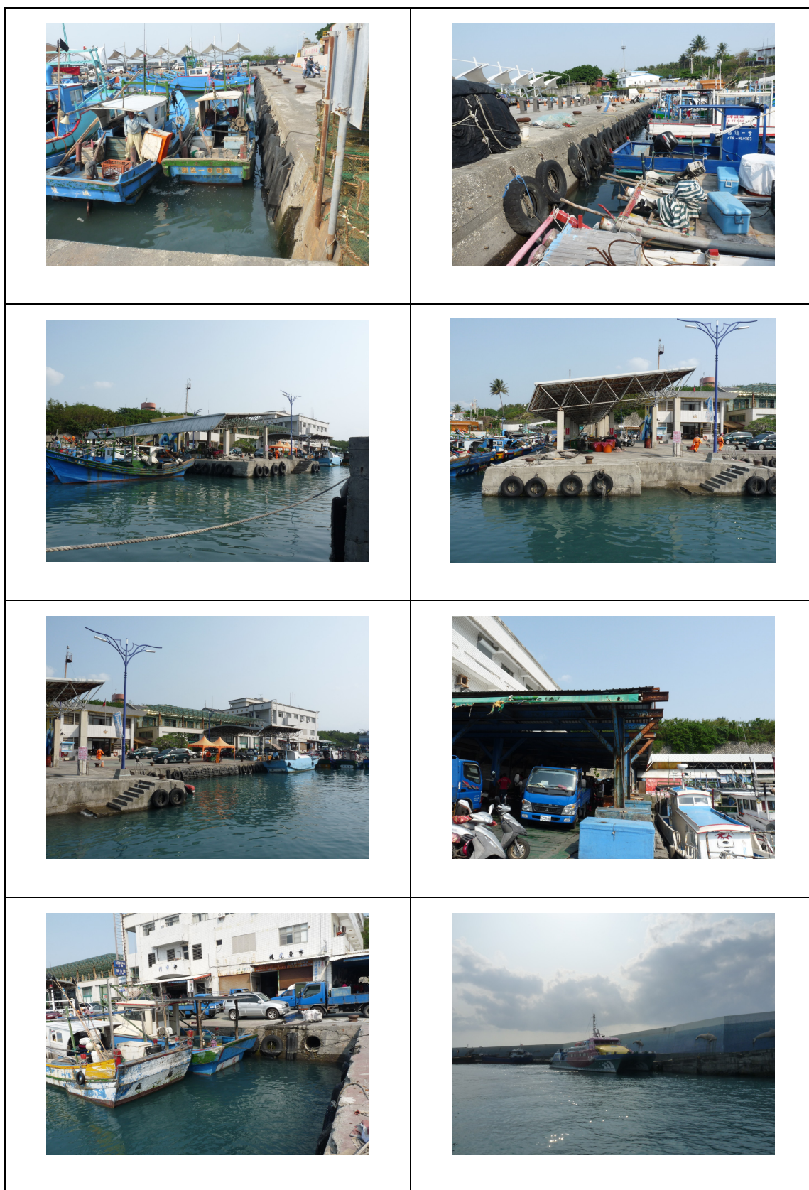
圖 3.95 富岡漁港現況情形 (101.3.29)
