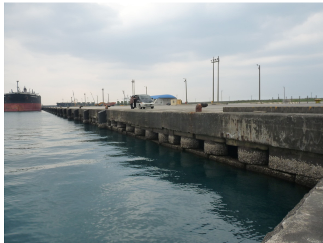
圖 3.43 花蓮港 23 號碼頭現況情形(101.3.27)
