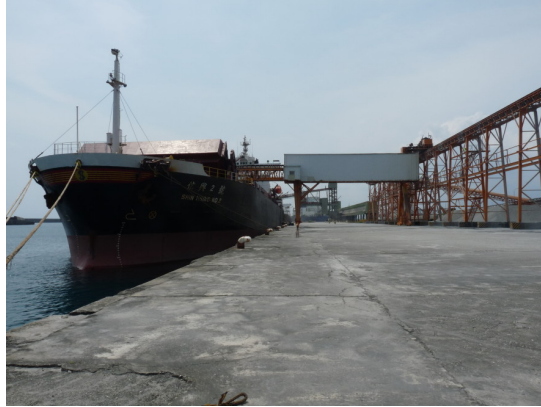
圖 3.36 花蓮港 18 號碼頭現況情形(101.3.27)
