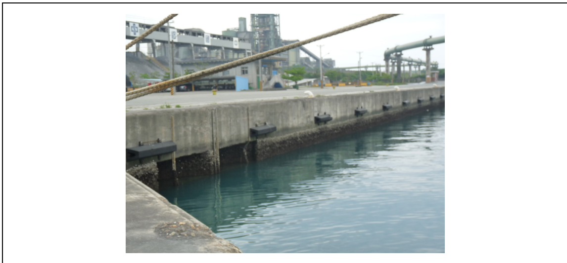
圖 3.28 花蓮港 12 號碼頭現況情形(101.3.26)
