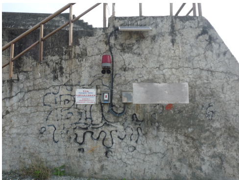
圖 3.73 長濱漁港防波堤及消波塊混凝土表面地圖狀裂縫 (101.3.29)
