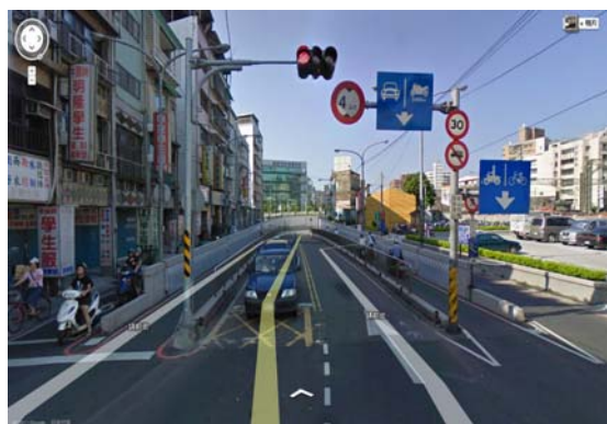
圖 3-8 新北市樹林區八德街地下道之車道配置（1 快車道、1 機車專用道）
