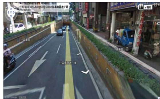
圖 10-4 臺北市中正區林森南路地下道之車道配置（2 快車道/禁行機車、1 機車專用道）
