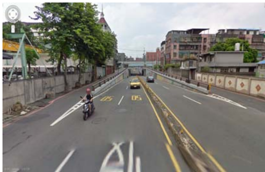
圖 3-3 新北市板橋區大觀路地下道之車道配置（1 快車道、1 混合車道）
