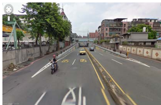
圖 10-3 新北市板橋區大觀路地下道之車道配置（1 快車道、1 混合車道）
