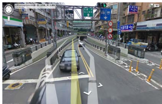
圖 3-6 新北市三重區力行路地下道之車道配置（1 快車道/禁行機車、1 機車專用道）
