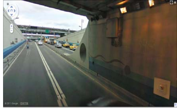
圖 3-2 臺北市松山區復興北路地下道之車道配置（1 快車道、1 混合車道）
