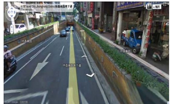
圖 3-4 臺北市中正區林森南路地下道之車道配置（2 快車道/禁行機車、1 機車專用道）
