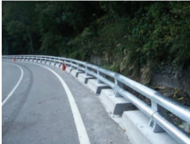
圖 4.4-3 台 9 線 356K+938-362K+945.5 水溝蓋板設置及路側安全防護設施改善
