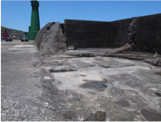
圖 4.7b #37 沉箱後側胸牆破壞情形
