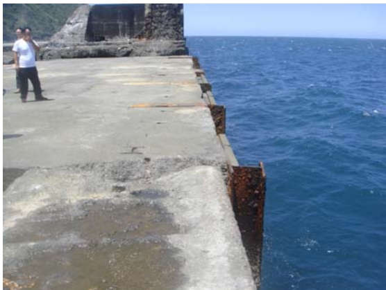
圖 4.11b #25~#26 沉箱前緣鋼版樁
