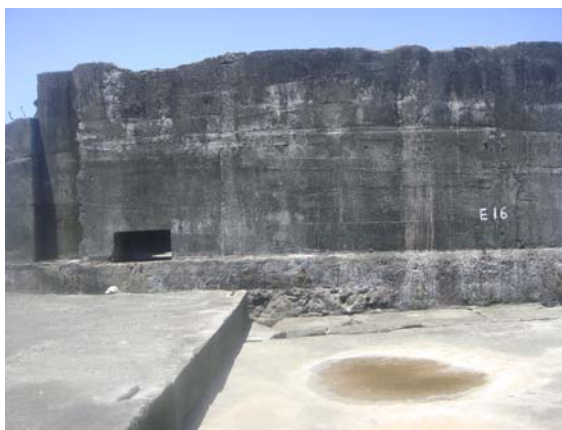
圖 4.25b 後側沉箱之剪力樁
