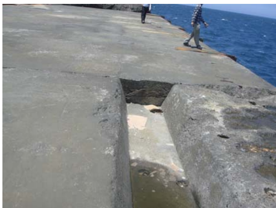
圖 4.25a 前側沉箱之剪力樁
