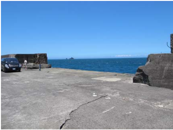
圖 4.11a #25~#26 沉箱破壞情形
