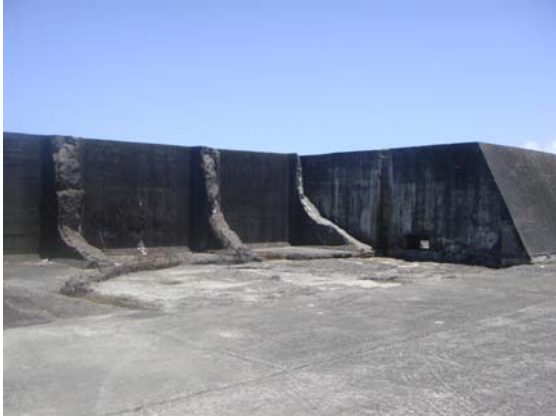
圖 4.7a #37 沉箱消波艙破壞情況
