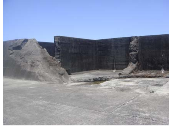
圖 4.7b #37 沉箱後側胸牆破壞情形
