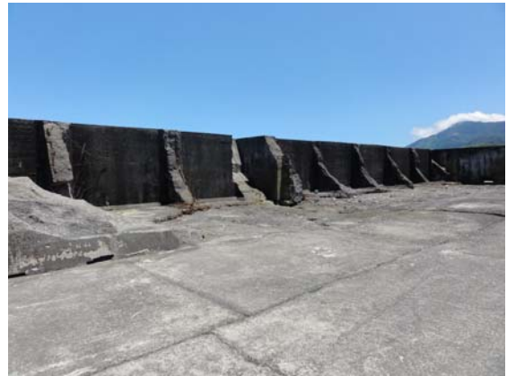
圖 4.8b #34、#35 沉箱後側胸牆破壞情形
