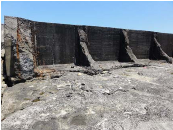
圖 4.8a #34、#35 沉箱消波艙破壞情況
