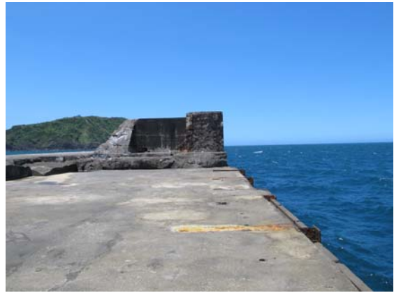
圖 4.11a #25~#26 沉箱破壞情形
