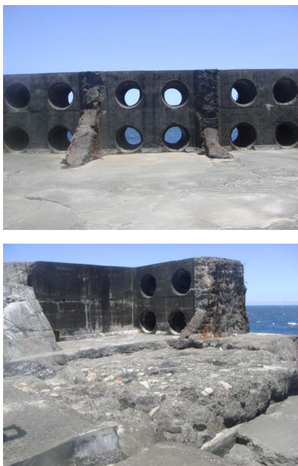
圖 4.23 消波倉破壞示意圖
