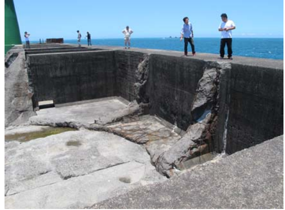
圖 4.7a #37 沉箱消波艙破壞情況
