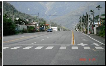
臺9丙（鯉魚潭）自行車道分隔導桿分隔
