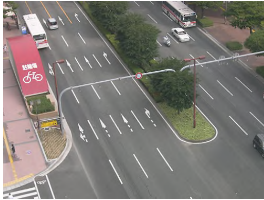
圖 2.14 路口處人行道邊緣平滑處理
