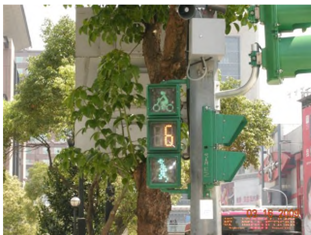
圖 3.60 行人專用號誌增設 1 個自行車專用號誌燈
