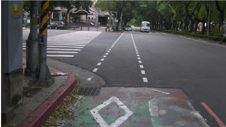
圖 3.52 自行車穿越道與行人穿越道分離（101 年 6 月，臺北市敦化南路）
