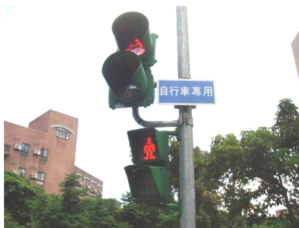
圖 3.61 行人專用號誌增設 1 個自行車專用號誌燈（101 年 5 月，臺北市羅斯福路）
