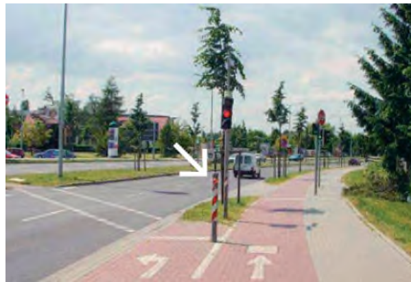
圖 7.5 自行車專用穿越手動觸控裝置(德國)[36]
