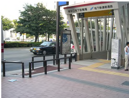
圖 2.13 車站出入口邊緣要求平滑處理
