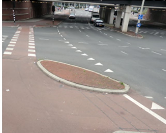
圖 2.17 轉角槽化的自行車設施設計
