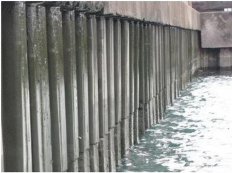
圖 3.4 典型鋼板樁碼頭構造情形
