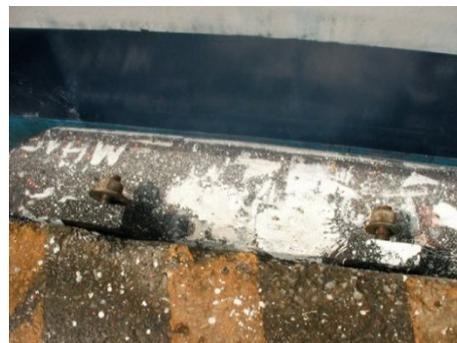
圖 4.35 基隆港東 2 號碼頭防舷材劣化異狀照片
