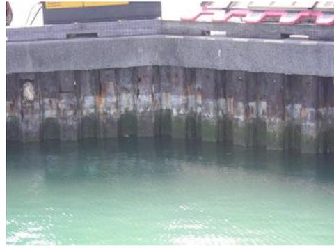
圖 3.5 典型鋼板樁碼頭構造銹損破壞現象
