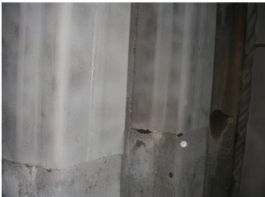
圖 3.6 典型鋼板樁碼頭構造局部破損穿孔現象
