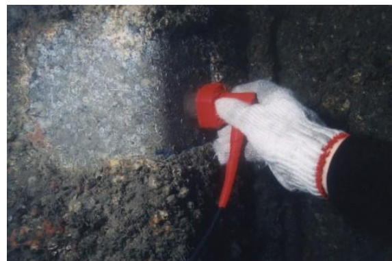
圖 7.9 鋼版樁厚度檢測情形
