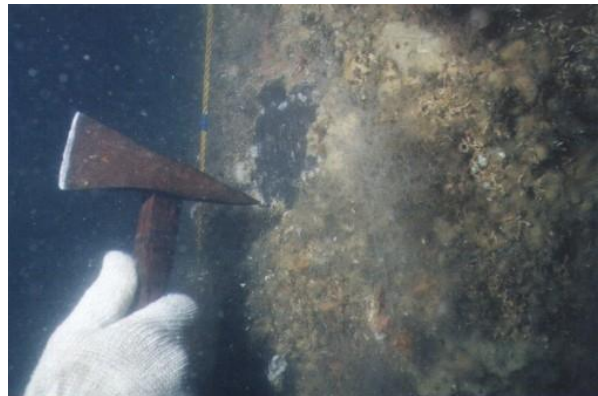
圖 7.7 清理鋼版樁表面附著海生物
