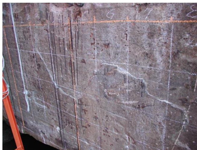
圖 4.1 碼頭岸壁面繪製方格
