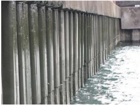
圖 7.4 典型鋼板樁碼頭構造情形
