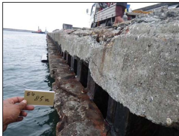
圖 3.35 岸肩混凝土剝落或鋼筋腐蝕外露情形(#4 ~ #5)
