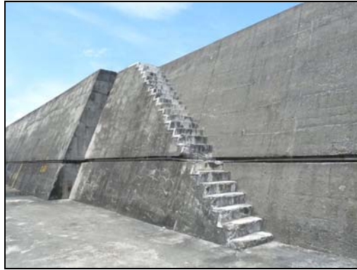
圖 3.41 防波堤堤身現況 (舊東堤)
