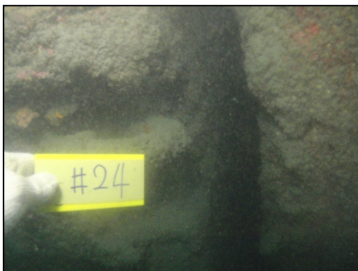
圖 3.49 沉箱接縫處間隙過大現況 (24 號碼頭)
