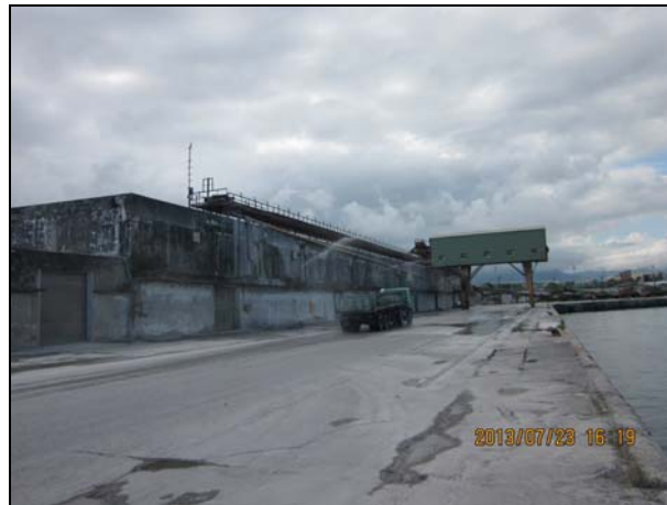
圖 3.34 碼頭面版龜裂、沈陷情形(#5 ~ #6)
