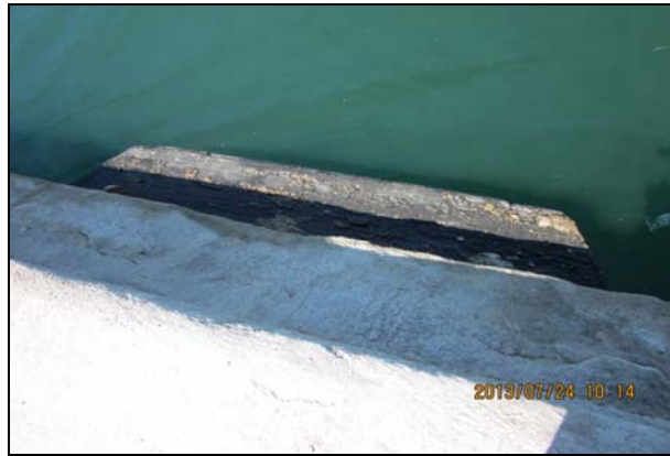
圖 3.36 護舷材破損、材質劣化情形
