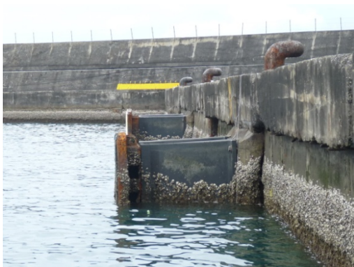
25 號碼頭岸壁及防舷材情形
