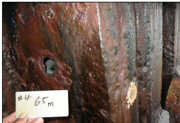
圖 3.38 飛沫帶鋼板樁表面腐蝕情形(#4 ~ #5)
