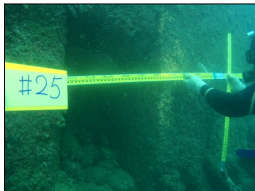
圖 3.50 沉箱接縫處間隙過大現況 (25 號碼頭)
