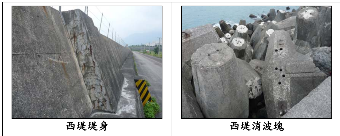
圖 3.43 西防波堤堤身及消波塊現況
