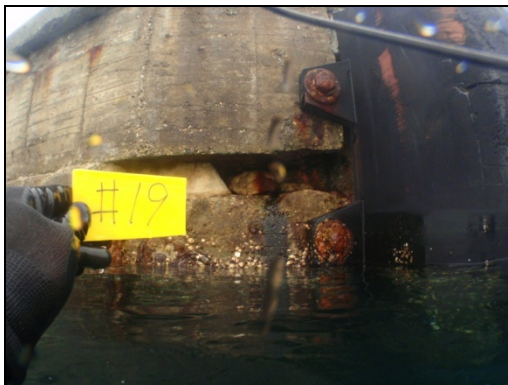
圖 3.47 混凝土接縫處劣損現況 (19 號碼頭)
