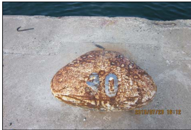
圖 3.37 繫船樁表面腐蝕情形
