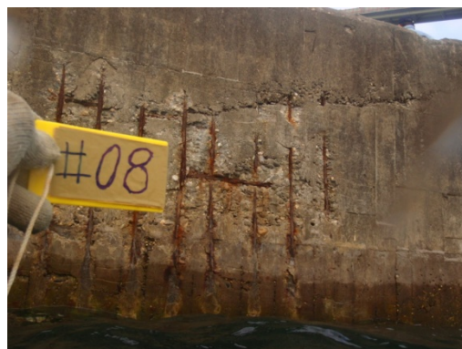
8 號碼頭岸壁劣化現況情形
