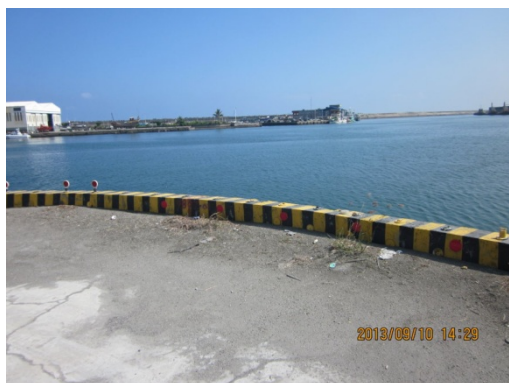
9 號碼頭岸肩現況情形 1
