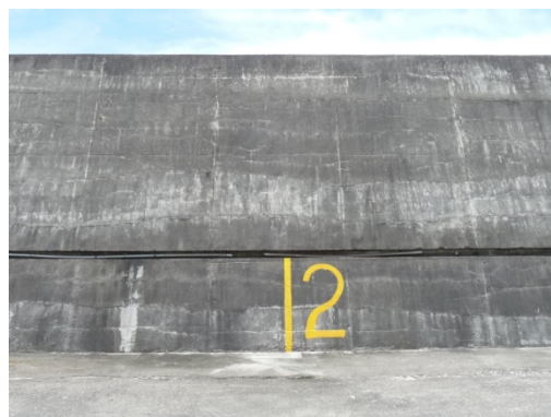
新東堤現況情形 4
