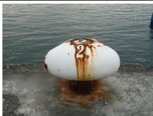
繫船柱現況情形 2
