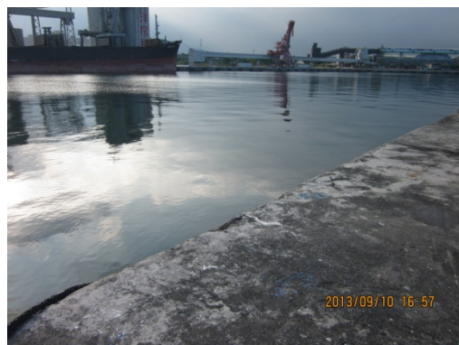
15 號碼頭岸肩現況情形 2
