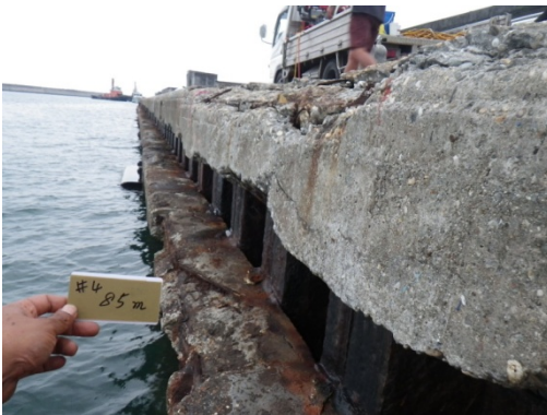
4 號碼頭岸壁橫梁現況情形
