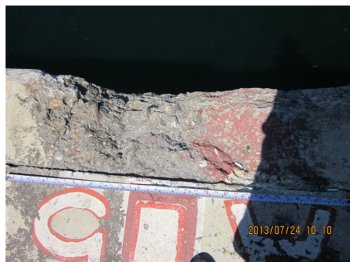
6 號碼頭岸肩現況情形
