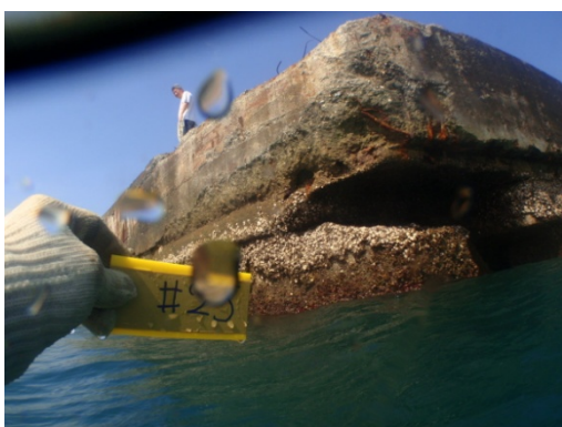
25 號碼頭岸壁現況情形
