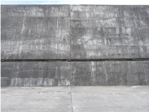
新東堤現況情形 5
