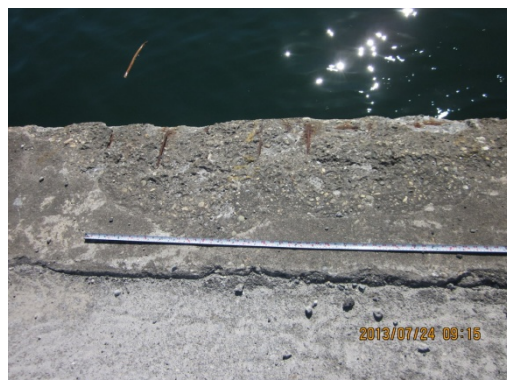
5 號碼頭岸肩現況情形
