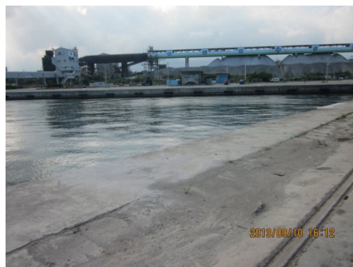
13 號碼頭岸肩現況情形 2
