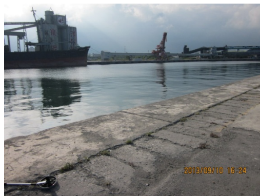
14 號碼頭岸肩現況情形 2
