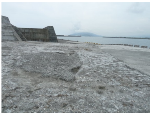
舊東堤現況情形 5
