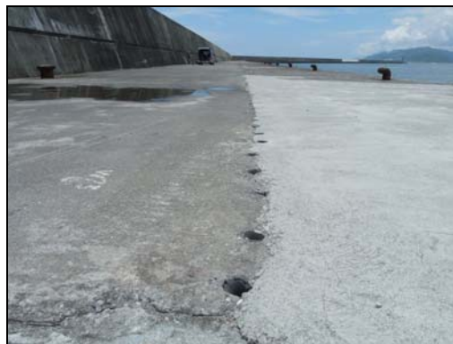
圖 4.8 防波堤堤面現況 (新東堤)
