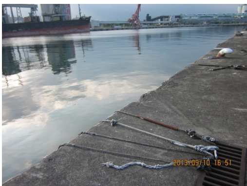
15 號碼頭岸肩現況情形 1
