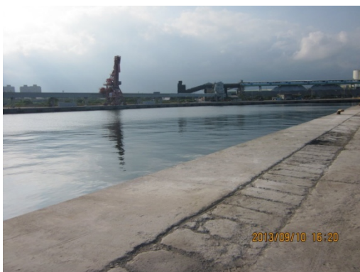
13 號碼頭岸肩現況情形 1
