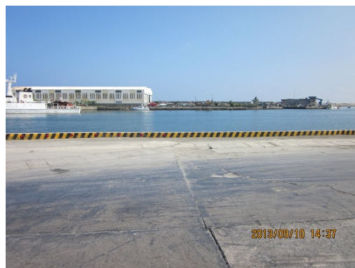
9 號碼頭岸肩現況情形 2
