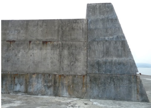
舊東堤現況情形 7
