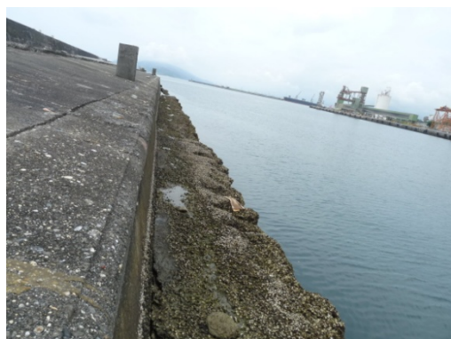
舊東堤現況情形 4
