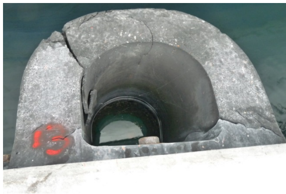
繫船柱現況情形 8
