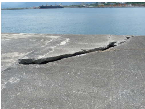
新東堤現況情形 3
