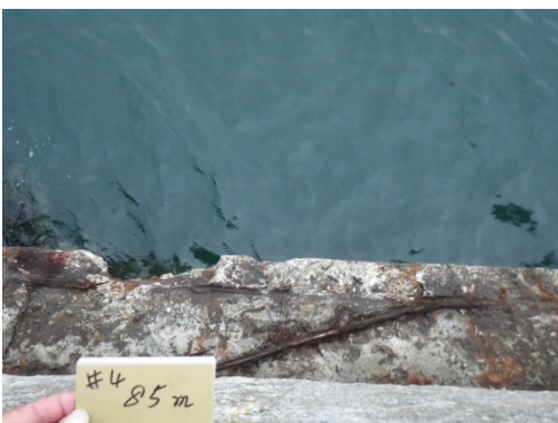
4 號碼頭岸肩現況情形
