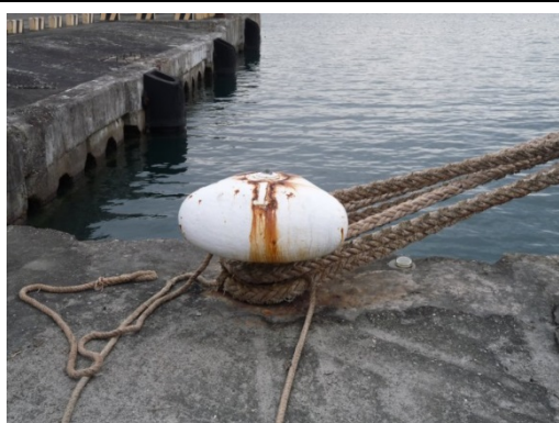
繫船柱現況情形 1
