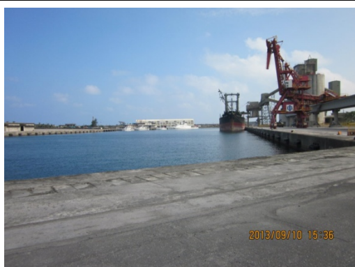
12 號碼頭岸肩現況情形 1
