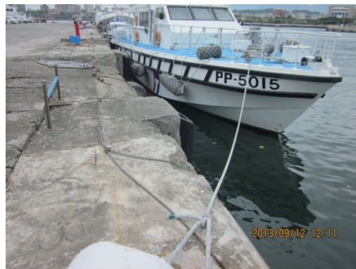
16 號碼頭岸肩現況情形 2
