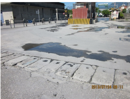
4 號碼頭岸肩排水設施現況情形
