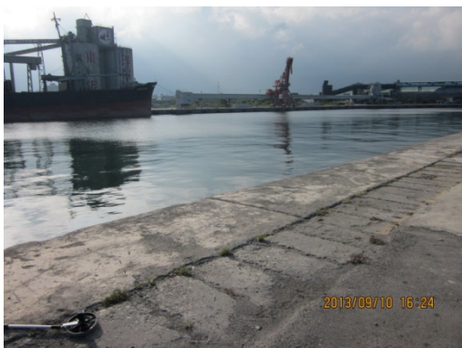
14 號碼頭岸肩現況情形 1
