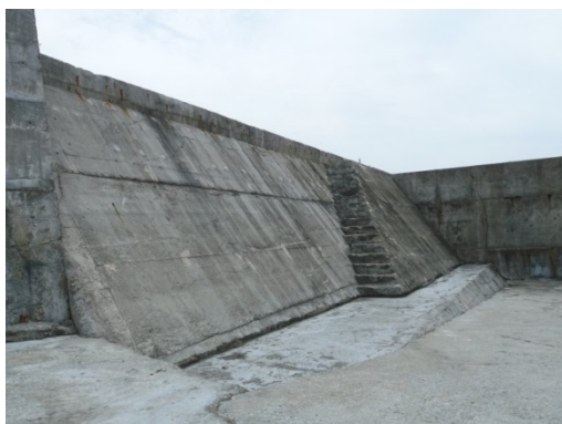
舊東堤現況情形 6
