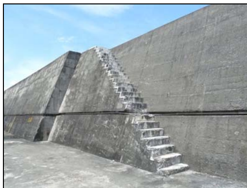
圖 4.9 防波堤堤身現況 (舊東堤)
