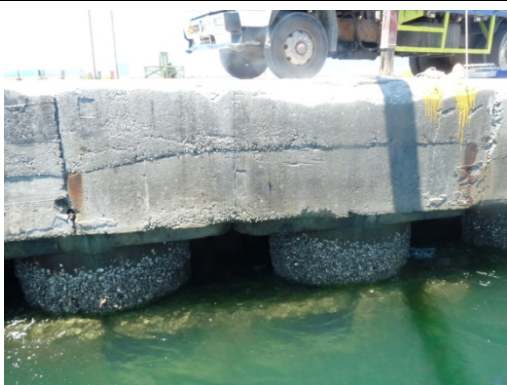
24 號碼頭岸壁現況情形 3
