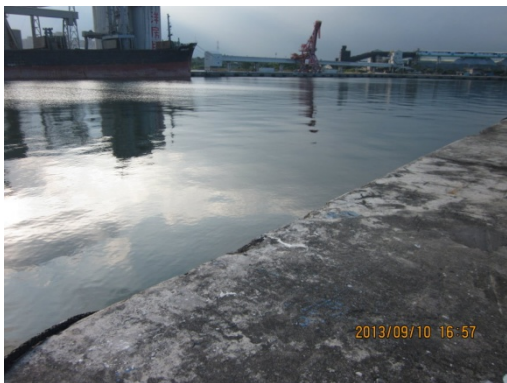
16 號碼頭岸肩現況情形 1
