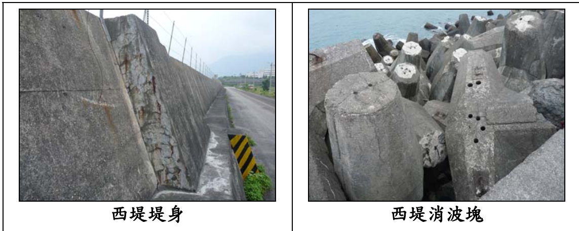
圖 4.11 西防波堤堤身及消波塊現況
