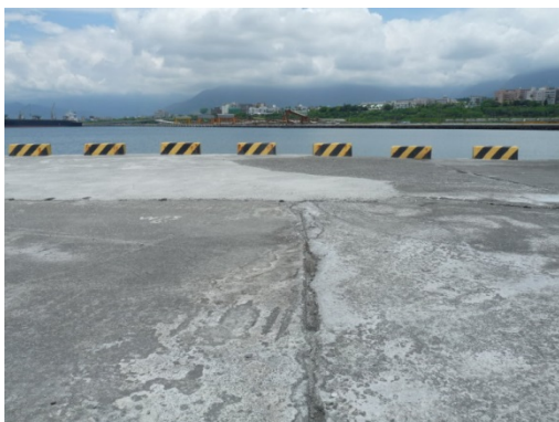
新東堤現況情形 1
