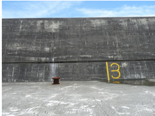
新東堤現況情形 6
