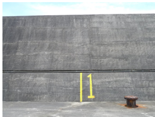
新東堤現況情形 2
