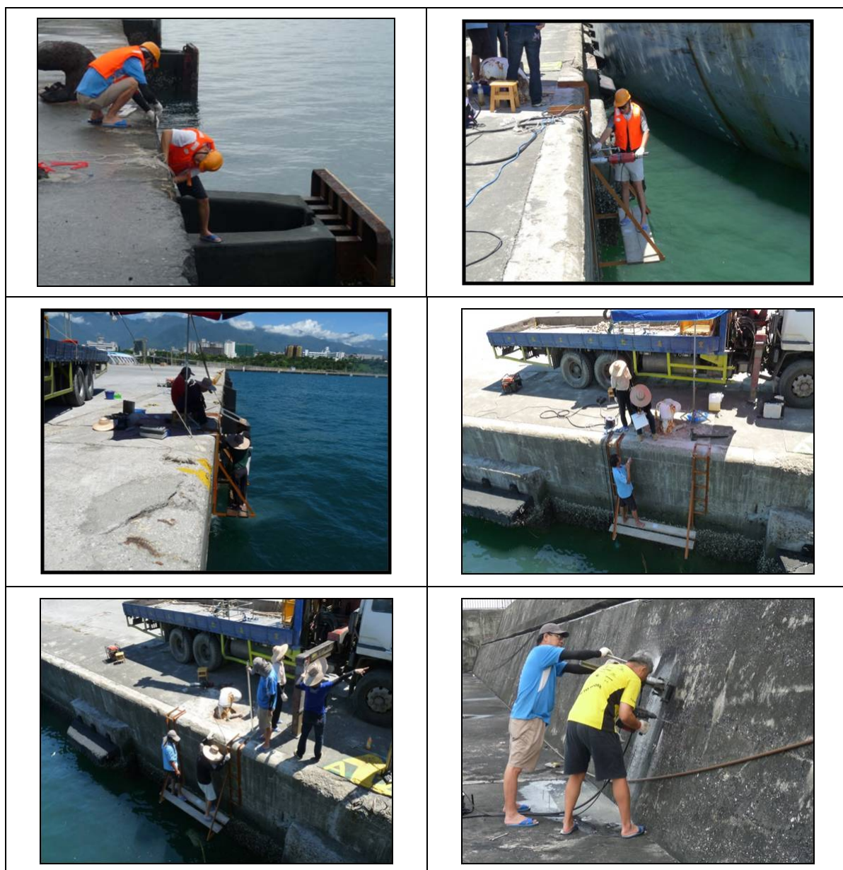
圖 4.12 非破壞性檢測現地作業情形
