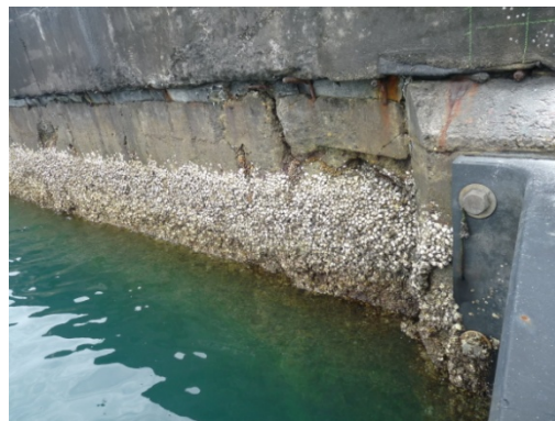
25 號碼頭岸壁現況情形
