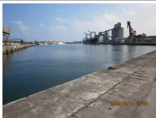
12 號碼頭岸肩現況情形 2
