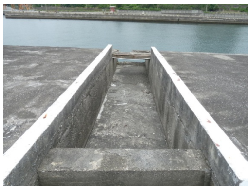
舊東堤現況情形 3
