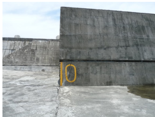
新、舊東堤銜接處現況情形
