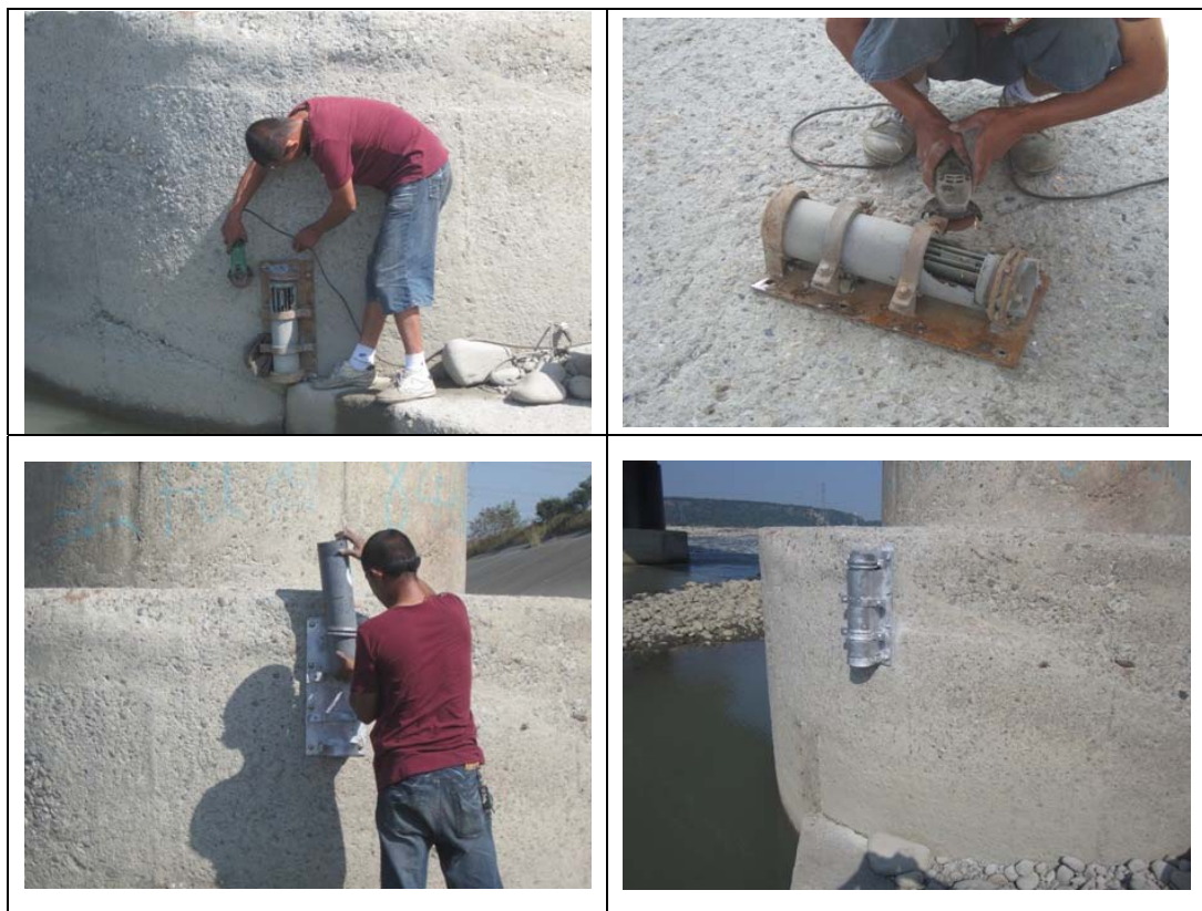
圖 2.19 更換水壓計安裝位置安裝新水壓計並加焊保護蓋 (2013 年 10 月 7 日)
