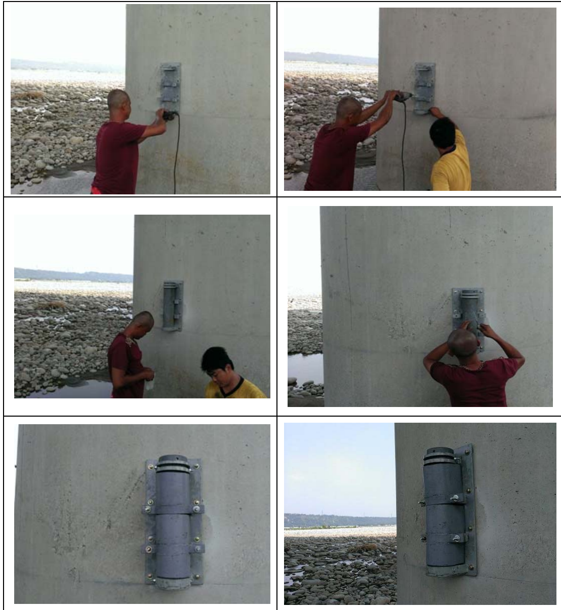
圖 2.17 水壓計安裝(2013 年 9 月 14 日)
