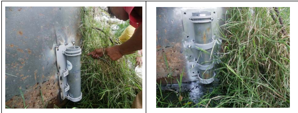
圖 2.9 水壓計安裝(2013 年 7 月 10 日)
