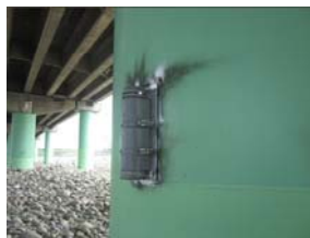
水壓計安裝(2013年9月14日)
