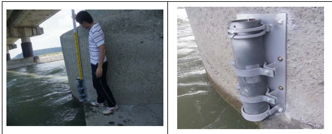
圖 2.18 水壓計安裝(2013 年 7 月 11 日)
