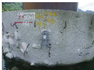
水壓計安裝(2013年7月10日)
