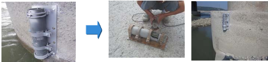
更換水壓計安裝位置安裝新水壓計並加 焊保護蓋 (2013年10月7日)
