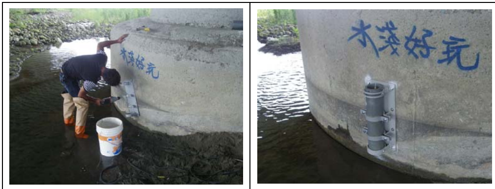
圖 2.20 水壓計安裝(2013 年 7 月 11 日)
