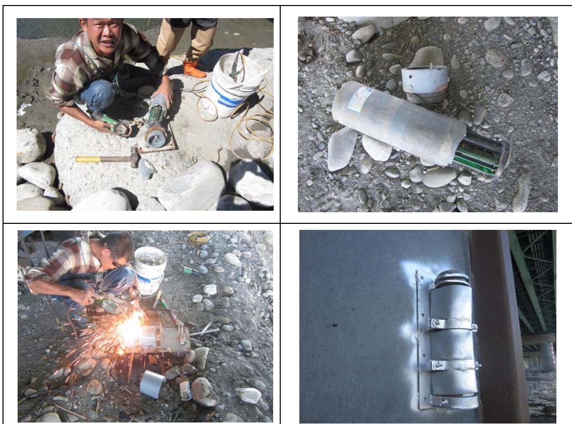
圖 2.10 儀器表面破損更換水壓計，並將鐵架加焊保護蓋及更改水壓計安裝位置
