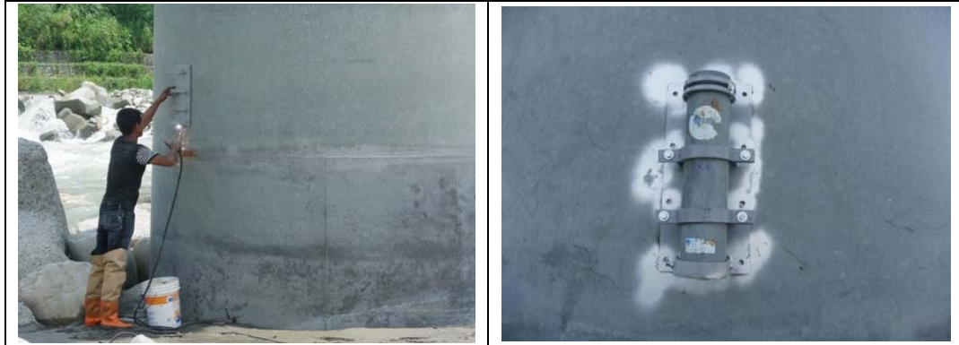
圖 2.11 水壓計安裝(2013 年 7 月 10 日)
