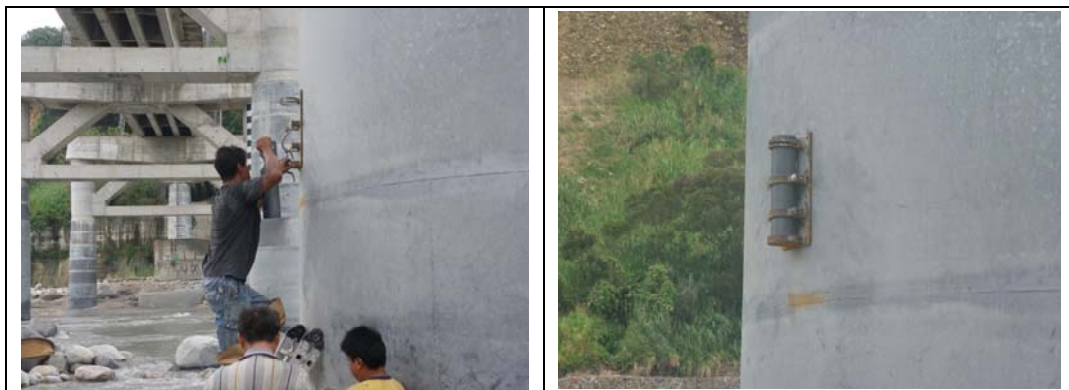
圖 2.12 水壓計取回並安裝新水壓計(2013 年 8 月 19 日)
