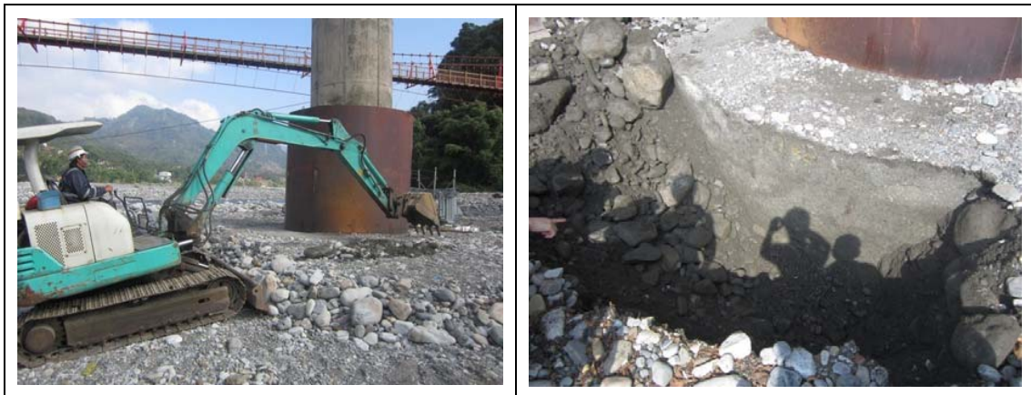
圖 2.8 水壓計及鐵架遺失(2013 月 11 月 27 日)
