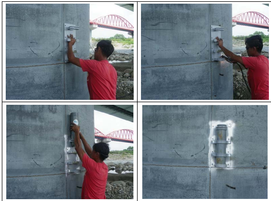
圖 2.14 水壓計安裝(2013 年 7 月 10 日)
