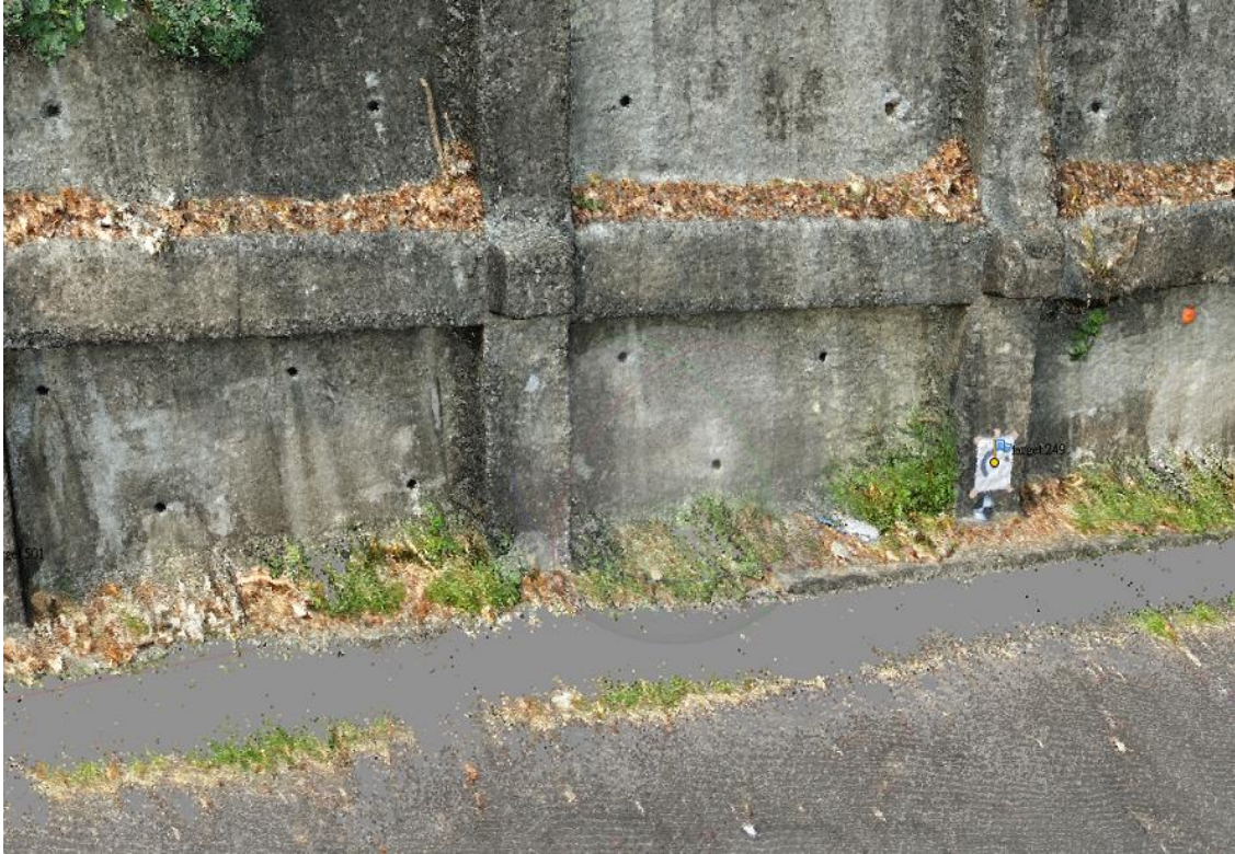
圖 4.8 邊坡穩定監測密集點雲圖
