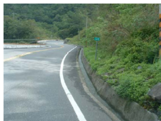
左：L 型邊溝(斜坡式邊溝) 右：U 型溝
