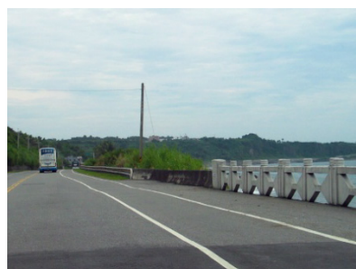
不同型式護欄混接
