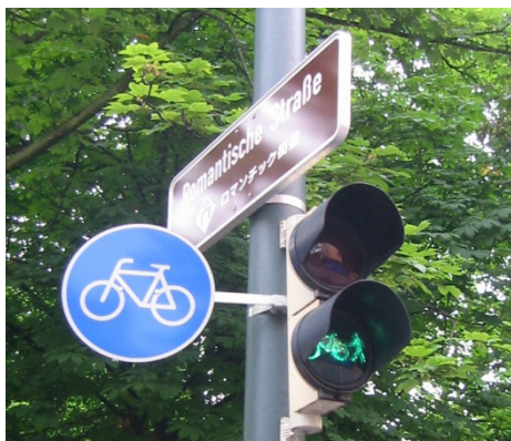
自行車穿越道線及自行車管制號誌燈號 自行車管制號誌燈號(併同行人)
