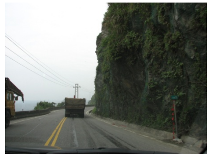
防落石掛網之邊坡壁面
