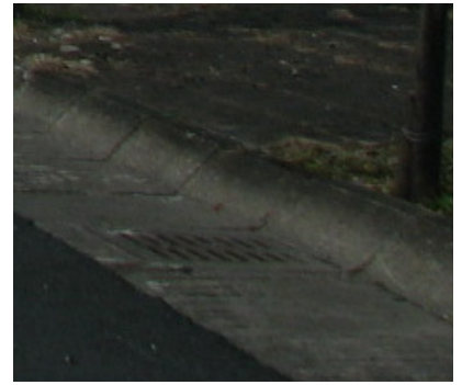
道路排水溝蓋板之鑄鐵溝蓋 RC 溝蓋髒污
