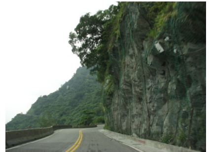
防落石掛網之邊坡壁面
