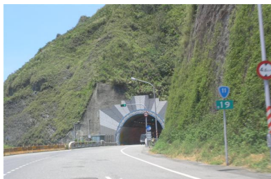
混凝土自由梁+掛網噴植
