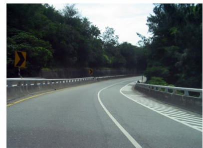
混凝土護欄+鋼管
