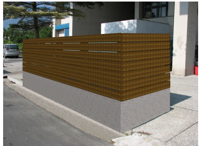
以自然材質之木材，設計電信箱外飾面
