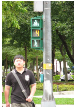
路側與行人共同設置之行車管制號誌燈號
