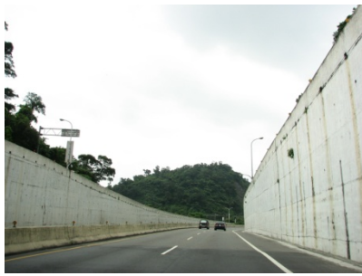
混凝土擋土牆(塗白色)
