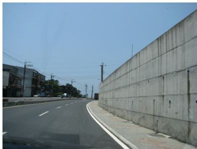
混凝土擋土牆
