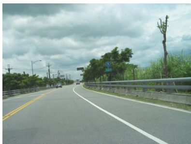
混凝土+鋼管護欄
