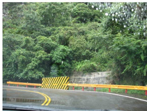
圖 4.3-11 台 8 線常用之交通安全防護設施(鋼板護欄)
