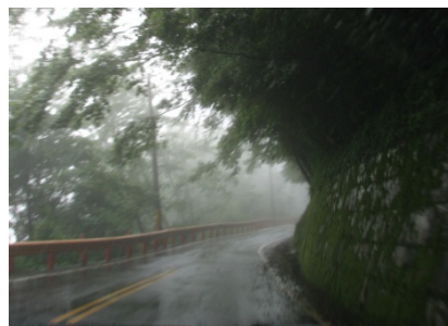
已被覆植生之混凝土擋土牆
