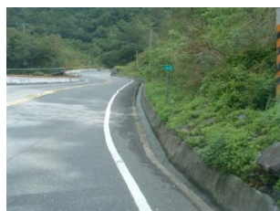
L 型邊溝(斜坡式邊溝) U 型溝
