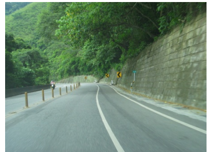
混凝土擋土牆(造型模板)
