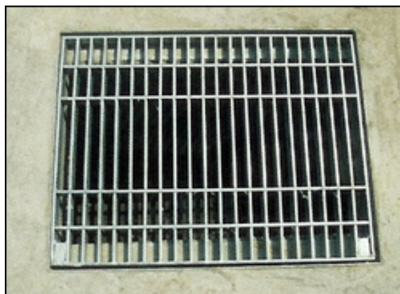
圖 3.2-3 主桿垂直道路之鍍鋅格柵蓋板 (資料來源： www.chengsing.com.tw/products-2.htm )
