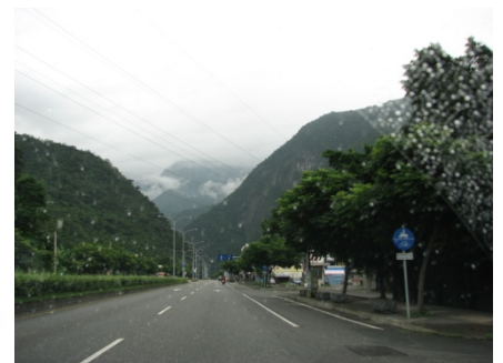
圖 4.3-7 台 8 線車道寬度類型一雙向四車道(具慢車道或路肩)
