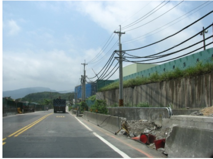
紐澤西護欄破損
