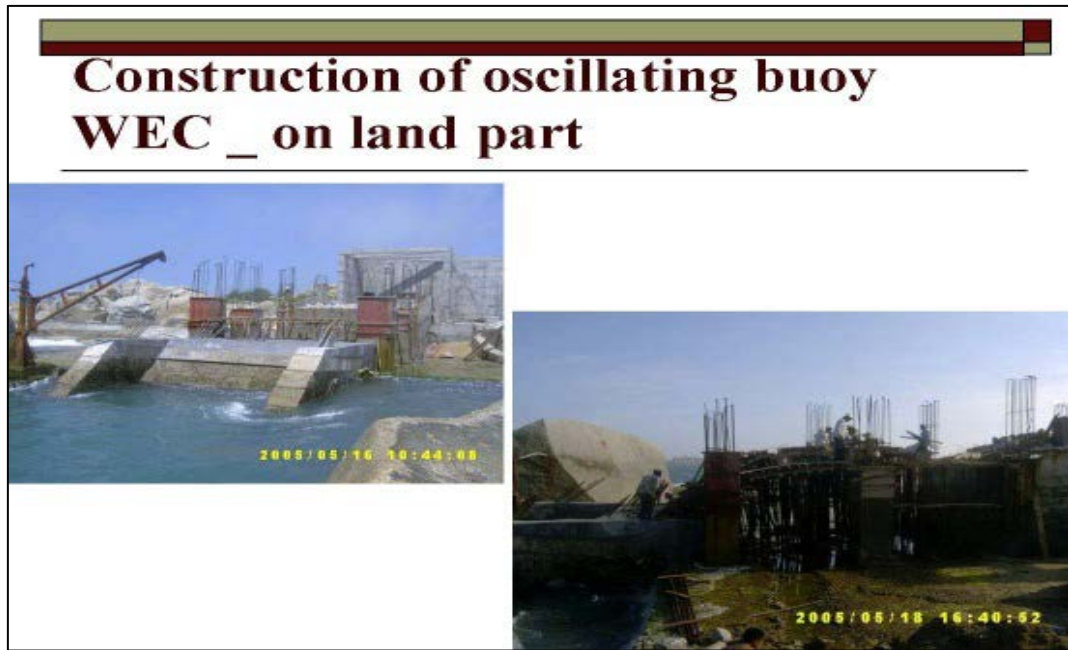
圖 3.7 波能轉換系統岸上設施建造施工情形
