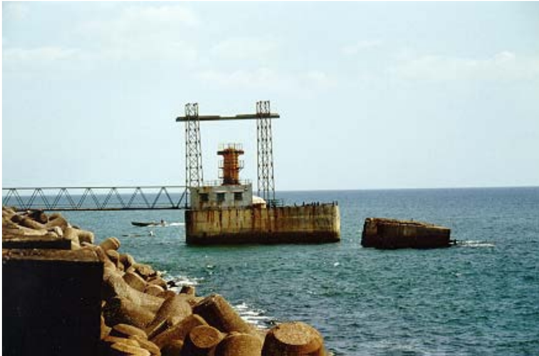
圖 3.12 Vizhinjam OWC 沉箱前防波堤結構
