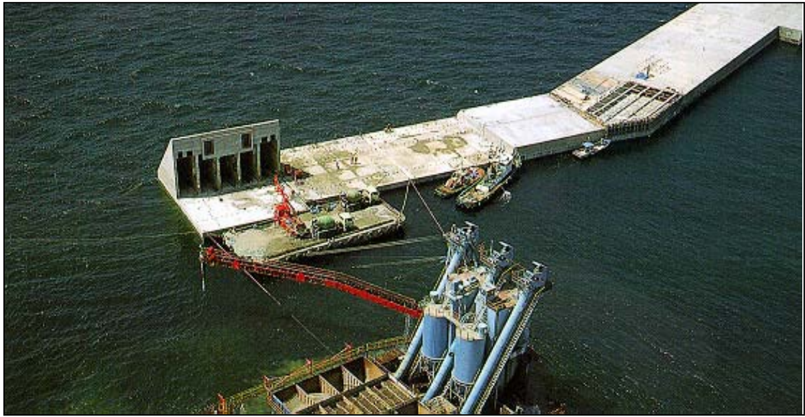
圖 3.17 Sakata OWC 的沉箱施工階段
