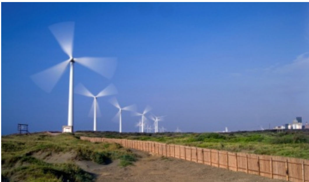
圖 2.10 觀園風力場址 (資料來源：臺灣電力公司網站)
