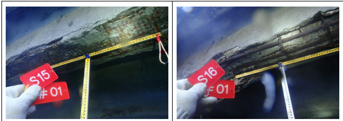
圖 3.48 基隆港西 10 號碼頭底版水下檢測照片
