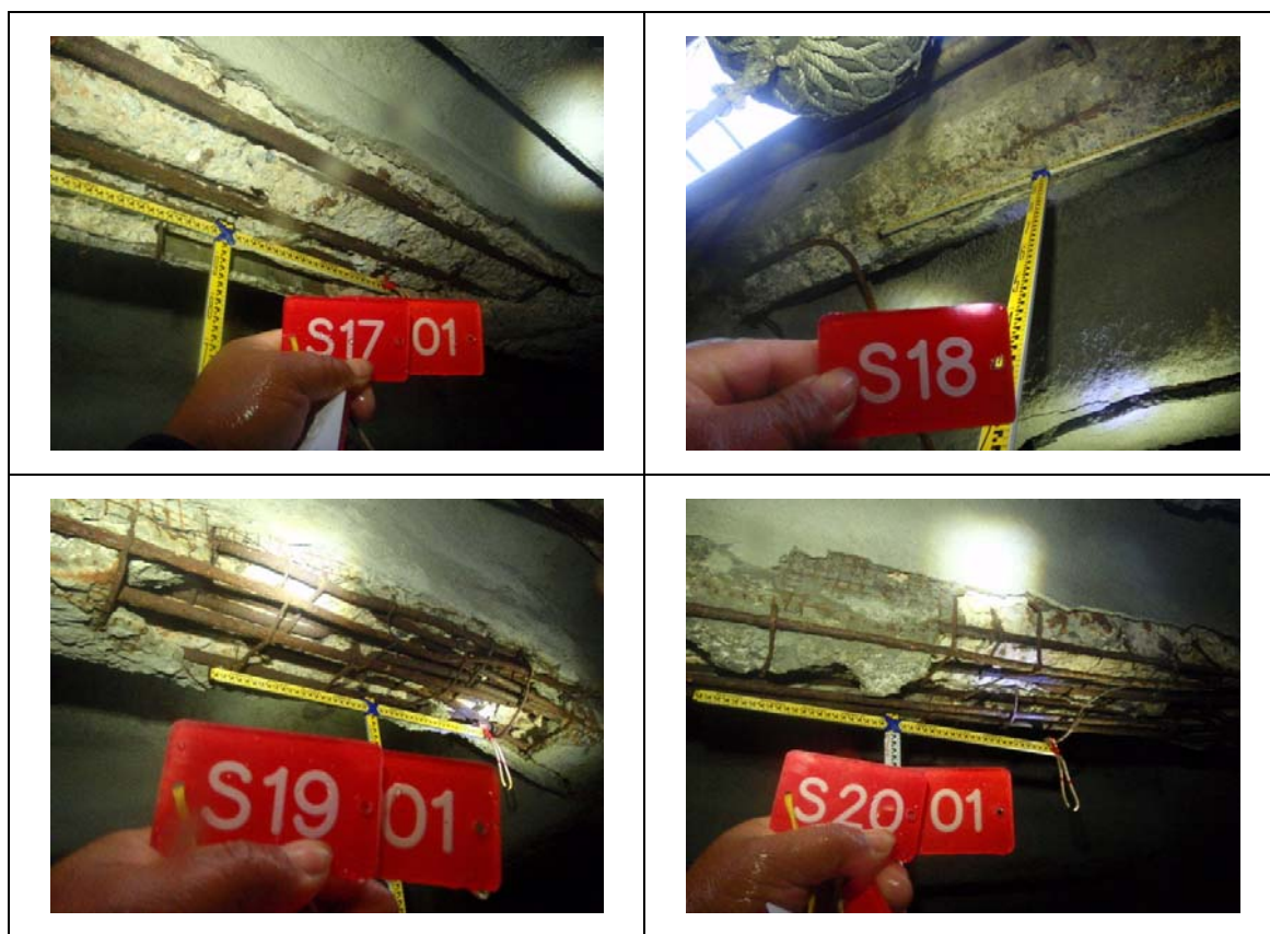
圖 3.46 基隆港西 9 號碼頭底版水下檢測照片
