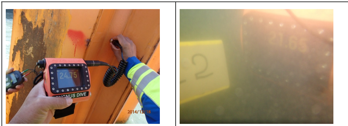
圖 3.63 浮動碼頭基樁鋼材厚度量測情形
