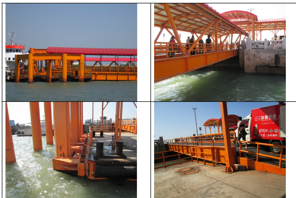
圖 3.62 浮動碼頭現地目視情形
