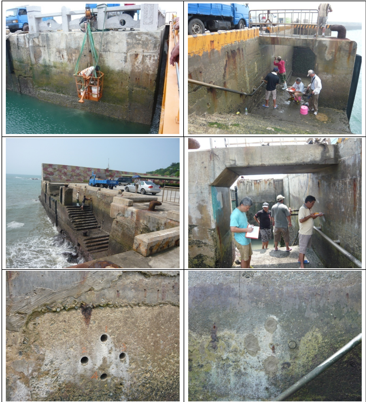
圖 3.65 非破壞性檢測現地作業情形
