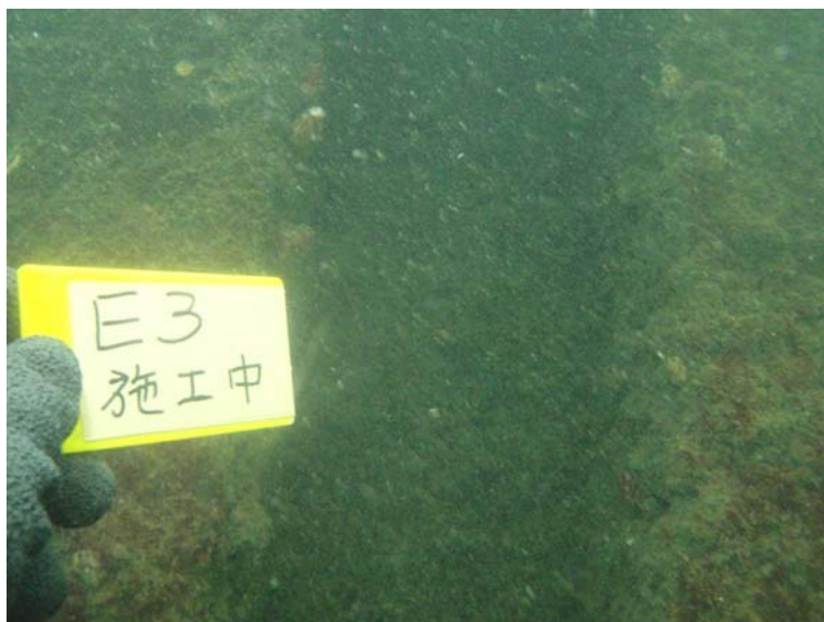
圖 3.38 基隆港東 3 碼頭鋼板樁外觀情形(103.8.13)
