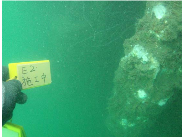
圖 3.35 基隆港東 2 碼頭鋼板樁外觀情形(103.8.12)
