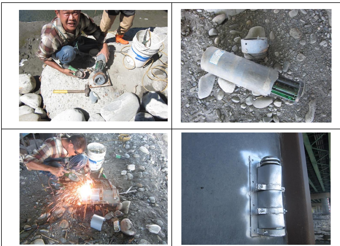
圖 2.10 儀器表面破損更換水壓計，並將鐵架加焊保護蓋及更改水壓計安裝位置(102 年 10 月 7 日)
