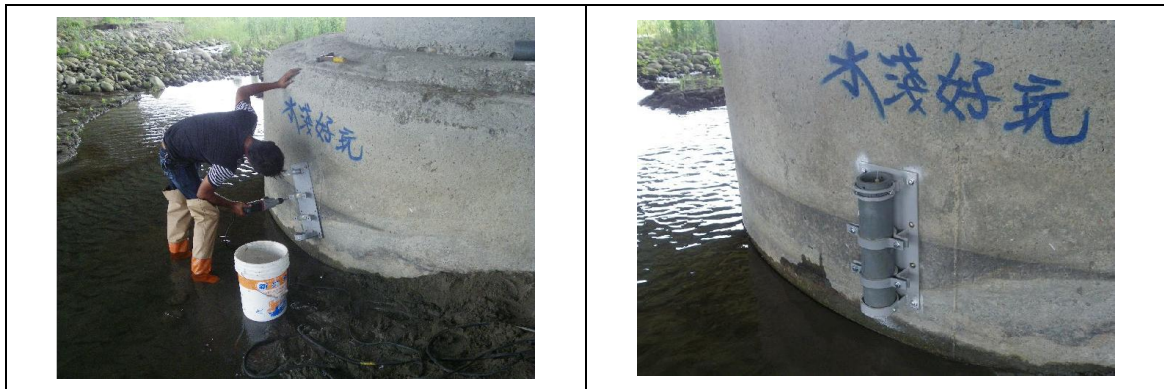
圖 2.26 水壓計安裝(102 年 7 月 11 日)
