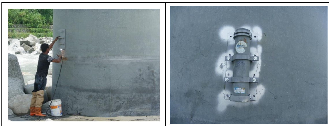
圖 2.12 水壓計安裝(102 年 7 月 10 日)
