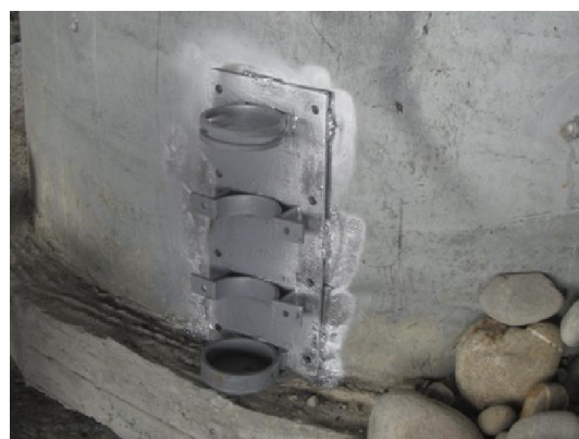
a. 新做儀器固定座及保護蓋 1 座並安裝水壓計腳架
