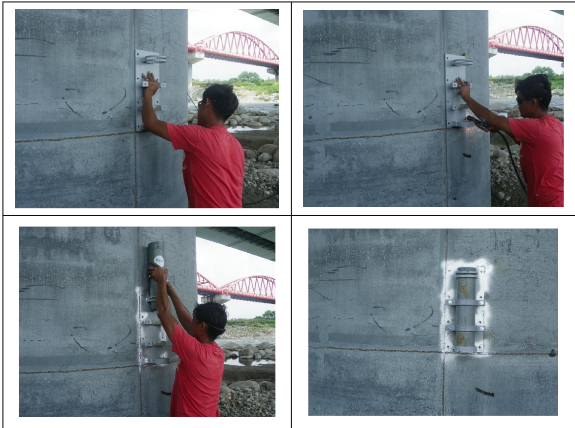
圖 2.16 水壓計安裝(102 年 7 月 10 日)
