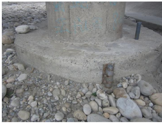
a. 拆解舊水壓計
