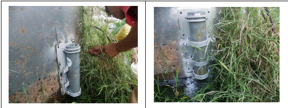
圖 2.9 水壓計安裝(102 年 7 月 10 日)
