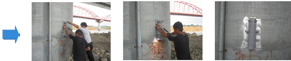
現場新設安裝水壓計一組(103年6月20日)
