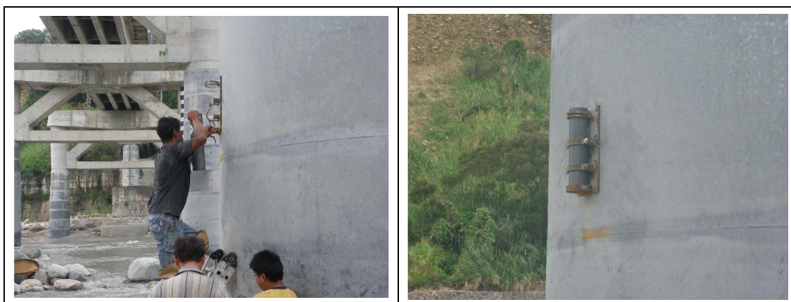
圖 2.13 水壓計取回並安裝新水壓計(102 年 8 月 19 日)
