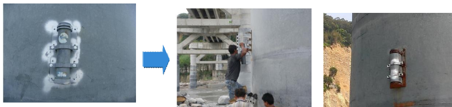
水壓計取回並安裝新水壓計(2013年8月19日) 及保護蓋加裝(2013年9月14日)
