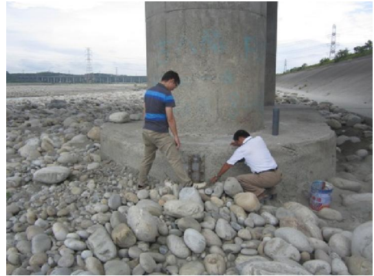
a. 拆解舊水壓計
