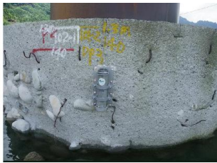
水壓計安裝(102年7月10日)
