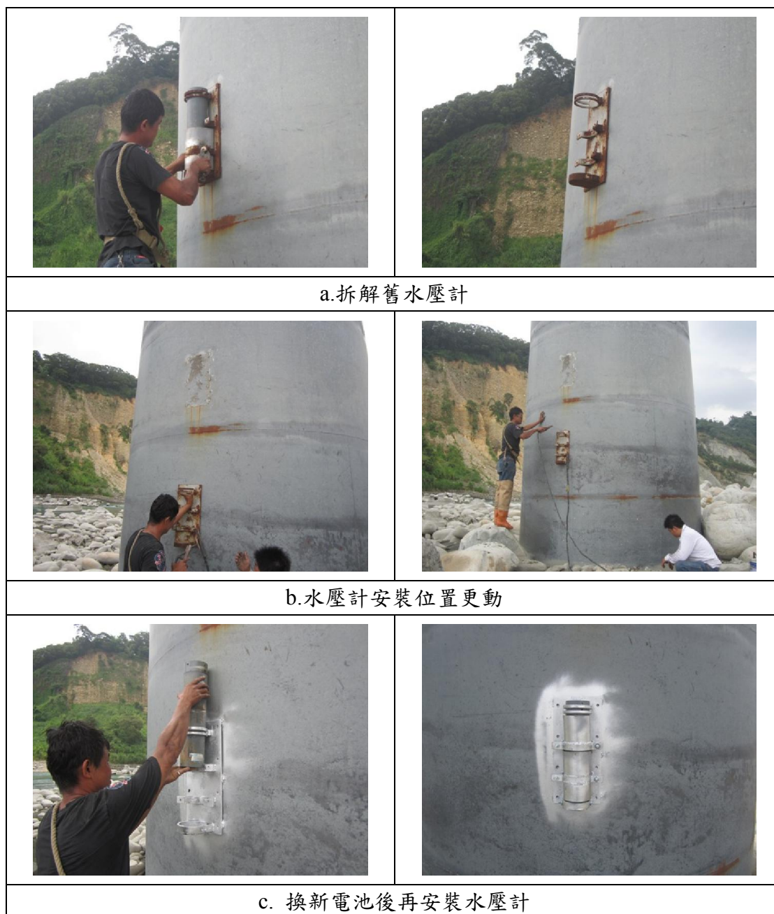
圖 2.15 拆解舊水壓計換新電池降低高程後再次安裝 (103 年 6 月 20 日)
