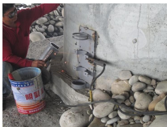
a. 新做儀器固定座及保護蓋 1 座並安裝水壓計腳架
