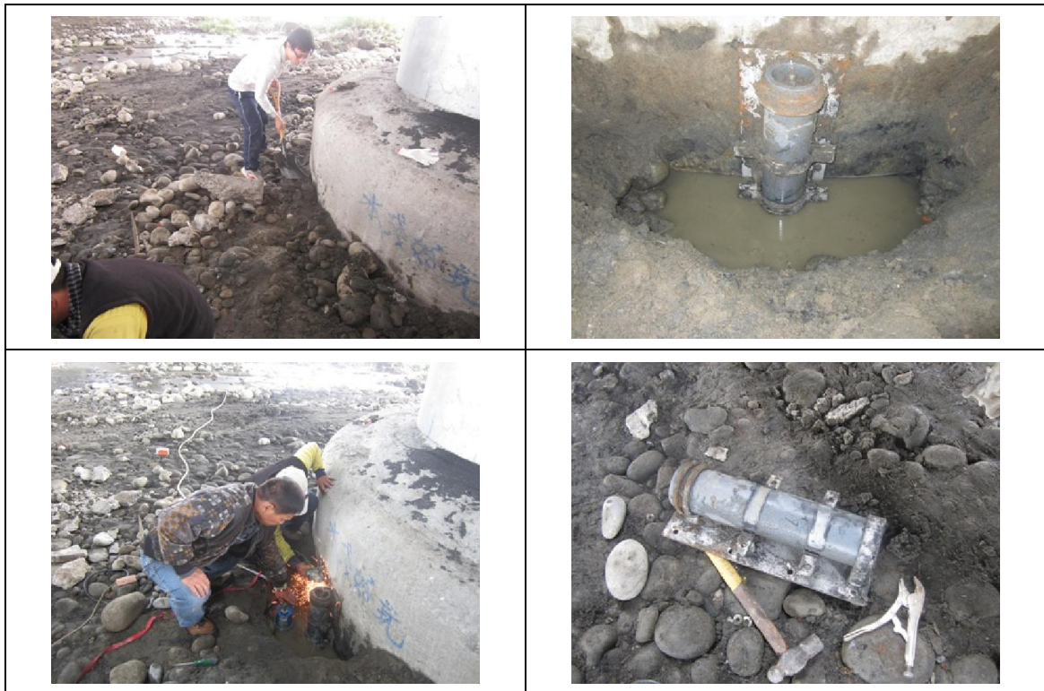
圖 2.27 水壓計及鐵架取回(102 年 11 月 20 日)
