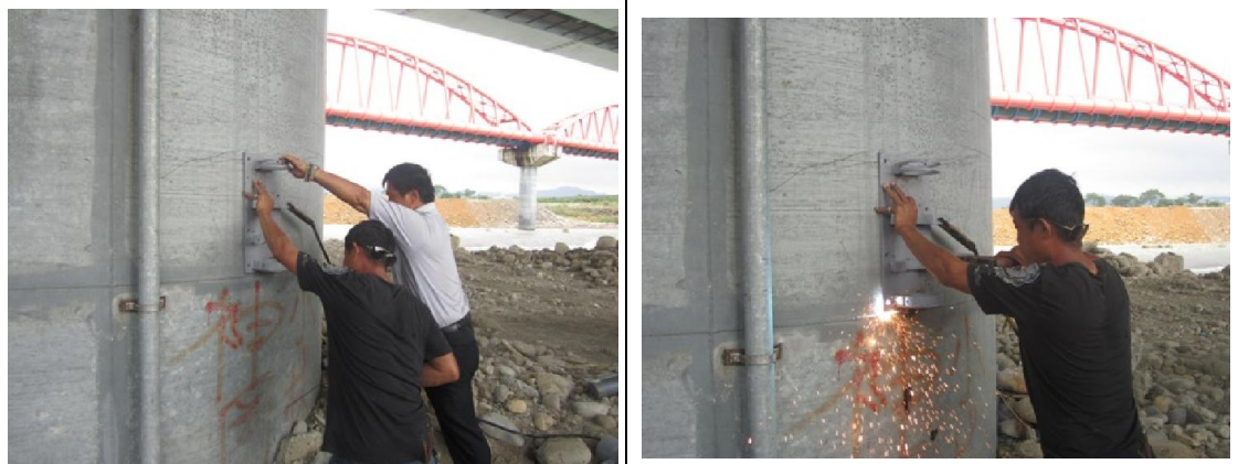
a. 安裝水壓計腳架
