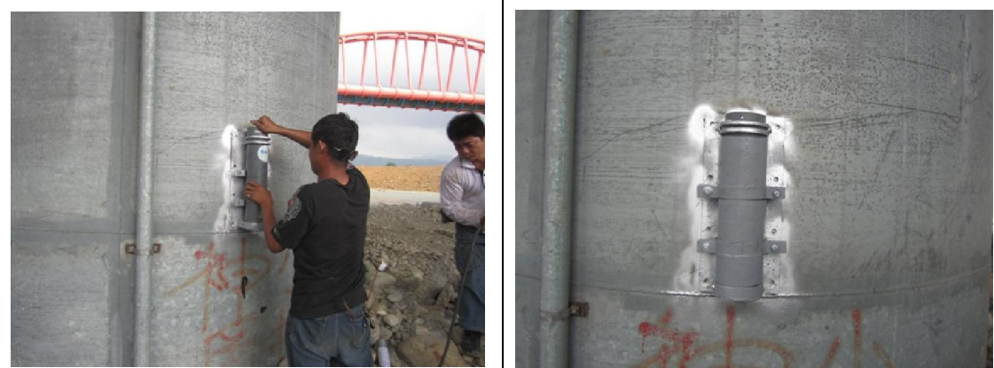
b. 新做保護蓋並安裝水壓計
