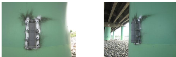
水壓計安裝(2013年9月14日)
