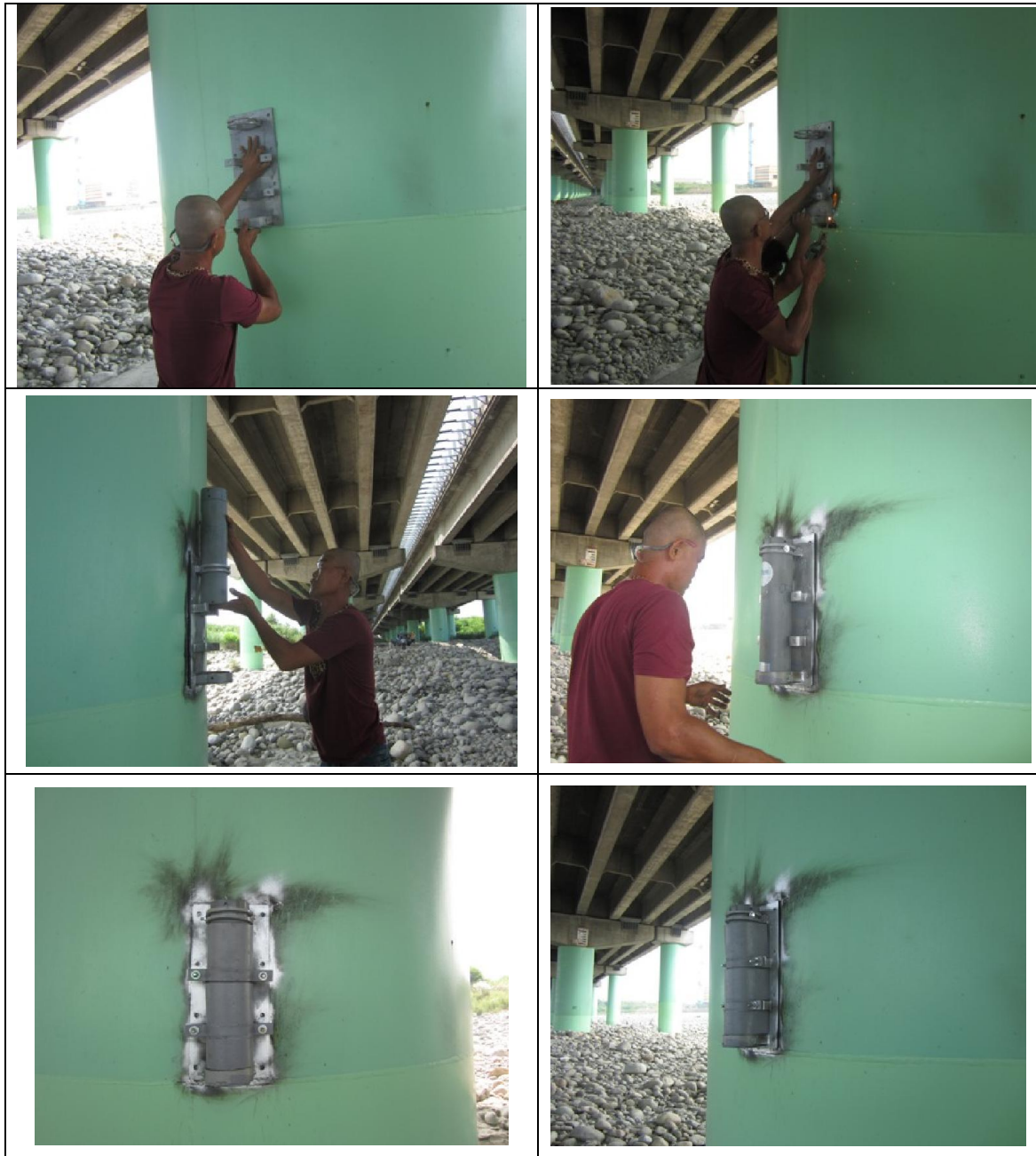
圖 2.19 水壓計安裝(102 年 9 月 14 日)
