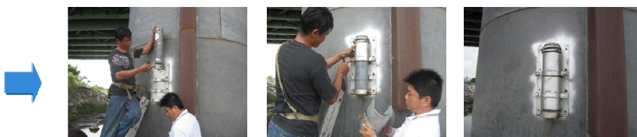
拆解舊水壓計換新電池後，再安裝(103年6月20日)
