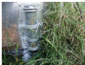
水壓計安裝(102年7月10日)
