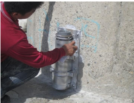
c. 換新電池後再安裝水壓計
