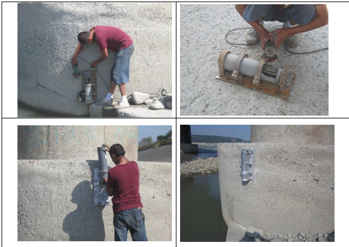
圖 2.24 更換水壓計安裝位置安裝新水壓計並加焊保護蓋 (102 年 10 月 7 日)
