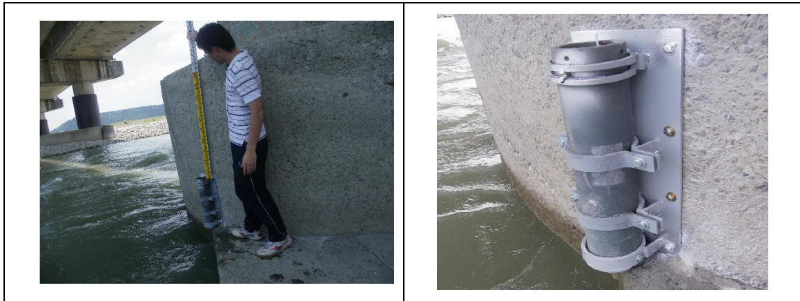
圖 2.23 水壓計安裝(102 年 7 月 11 日)
