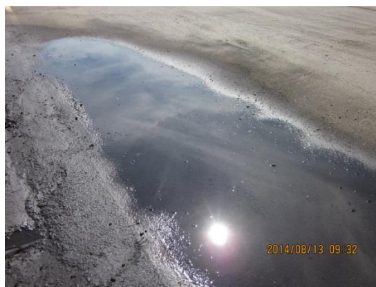
圖 5.30 東 7 號碼頭單元 1 岸肩沉陷
