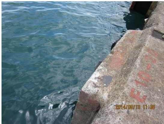
圖 5.35 東 10 號碼頭單元 5 防舷材掉落
