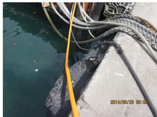
圖 5.40 東 16 號碼頭單元 5 防舷材構件變形
