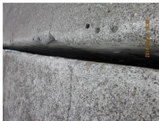
圖 5.46 東防波堤單元 25 接縫位移
