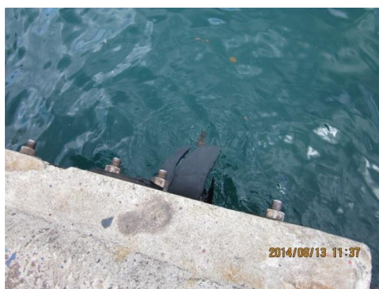
圖 5.34 東 10 號碼頭單元 4 防舷 材掉落
