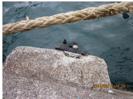
圖 5.38 東 14 號碼頭單元 2 防舷材構件變形
