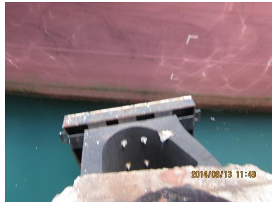
圖 5.36 東 11 號碼頭單元 3 防舷材掉落
