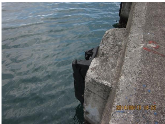
圖 5.37 東 12 號碼頭單元 4 防舷材構件變形
