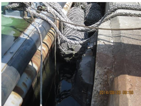
圖 5.39 東 16 號碼頭單元 2 防舷材構件變形
