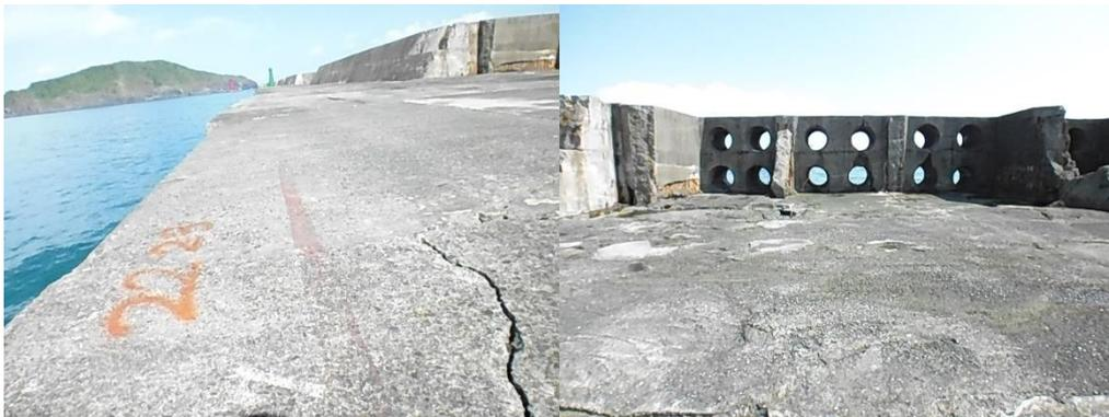
圖 4.6e 沉箱#S23 堤體情況(僅剩開孔胸牆)
