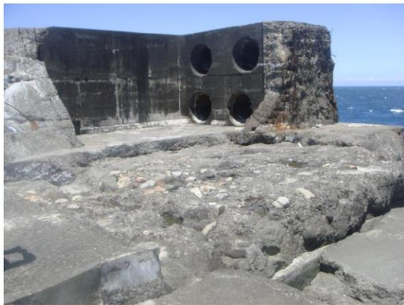
圖 4.22 消波倉破壞示意圖
