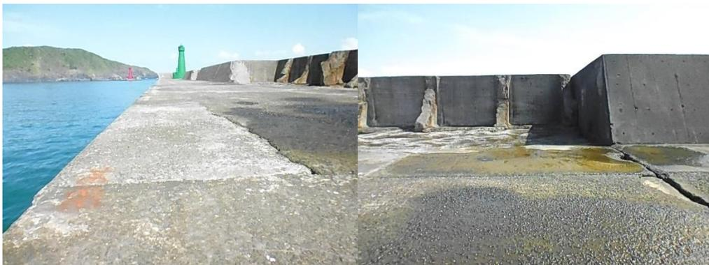
圖 4.6i 沉箱#S34 堤體情況(胸牆部分損毀、海水滲入)
