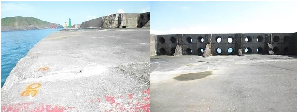
圖 4.6h 沉箱#S31 堤體情況(僅剩開孔胸牆、海水滲入)
