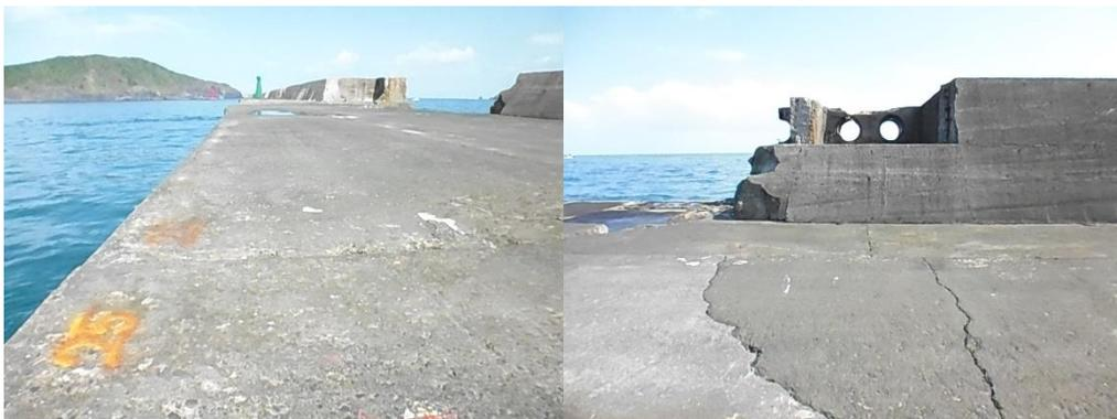
圖 4.6f 沉箱#S26 堤體情況(胸牆局部損壞)
