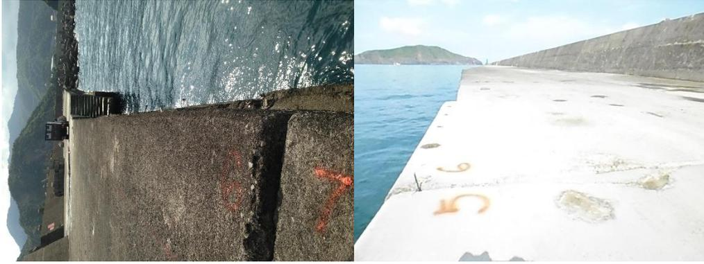
圖 4.6a 沉箱#S06 堤體情況(沉箱歪斜)
