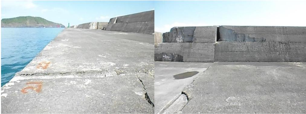
圖 4.6d 沉箱#S22 堤體情況(胸牆局部損壞)
