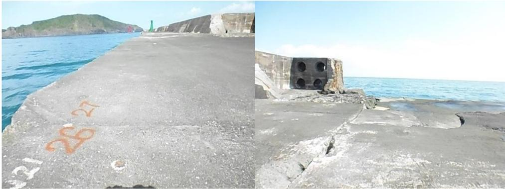
圖 4.6g 沉箱#S27 堤體情況(無胸牆、堤面破損、沉箱有位差)
