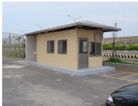
圖 4.15 臺北港北 2 碼頭工寮現況
