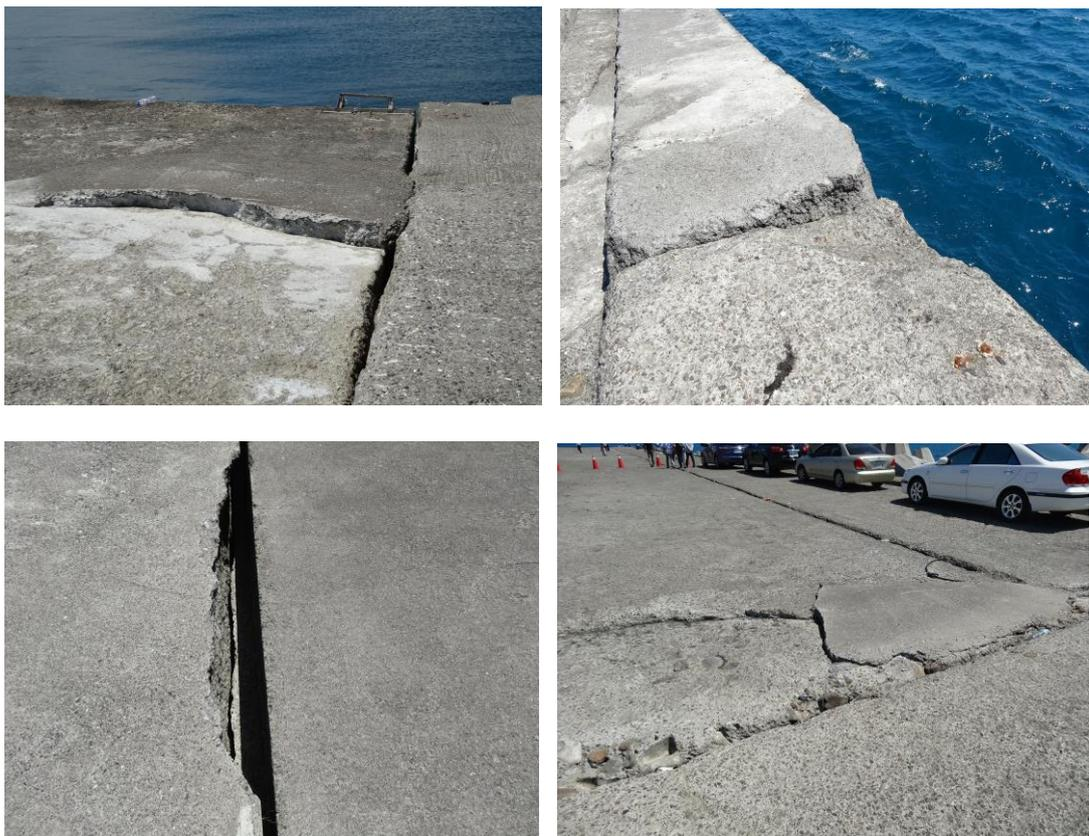
圖 5.7 堤面與接縫破損情況
