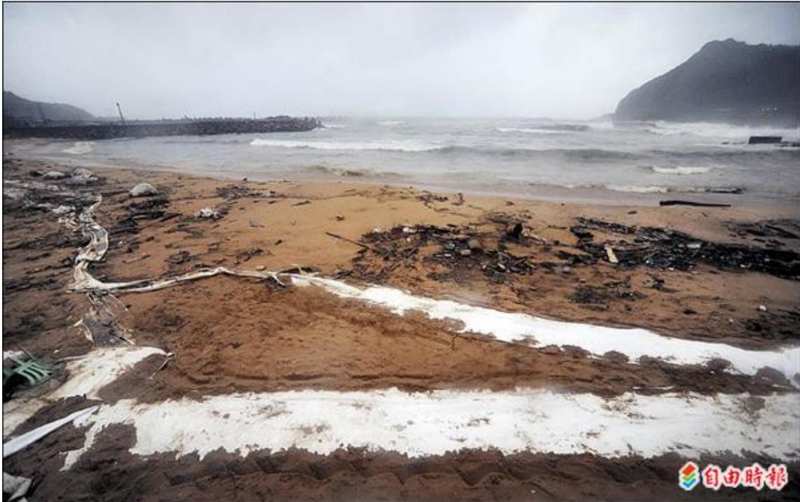
圖 3.24 瑞興輪大量重油外洩造成嚴重污染，新北市環保局派員在岸邊鋪設攔油索(圖片來源：自由日報)
