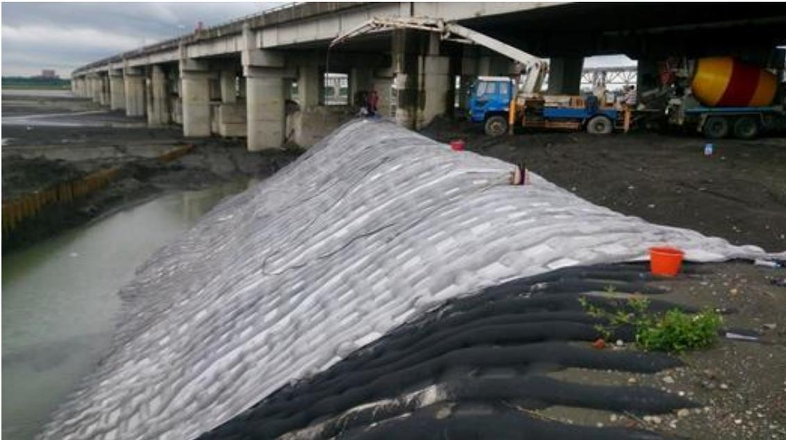
圖 6.1 砂腸袋配合織物模板保護工
