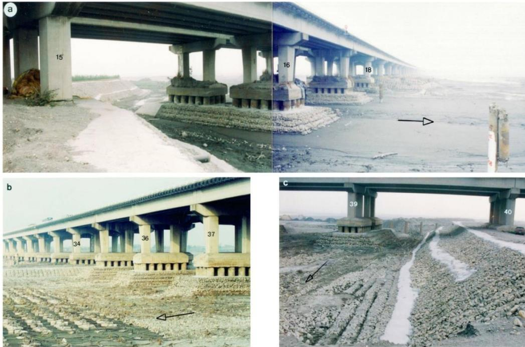
圖 3.2 中沙大橋橋墩保護工
