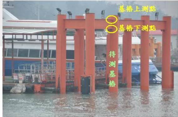
藉由全測站，針對基樁上、下視點進行兩次傾斜量測，以監測其傾斜量
