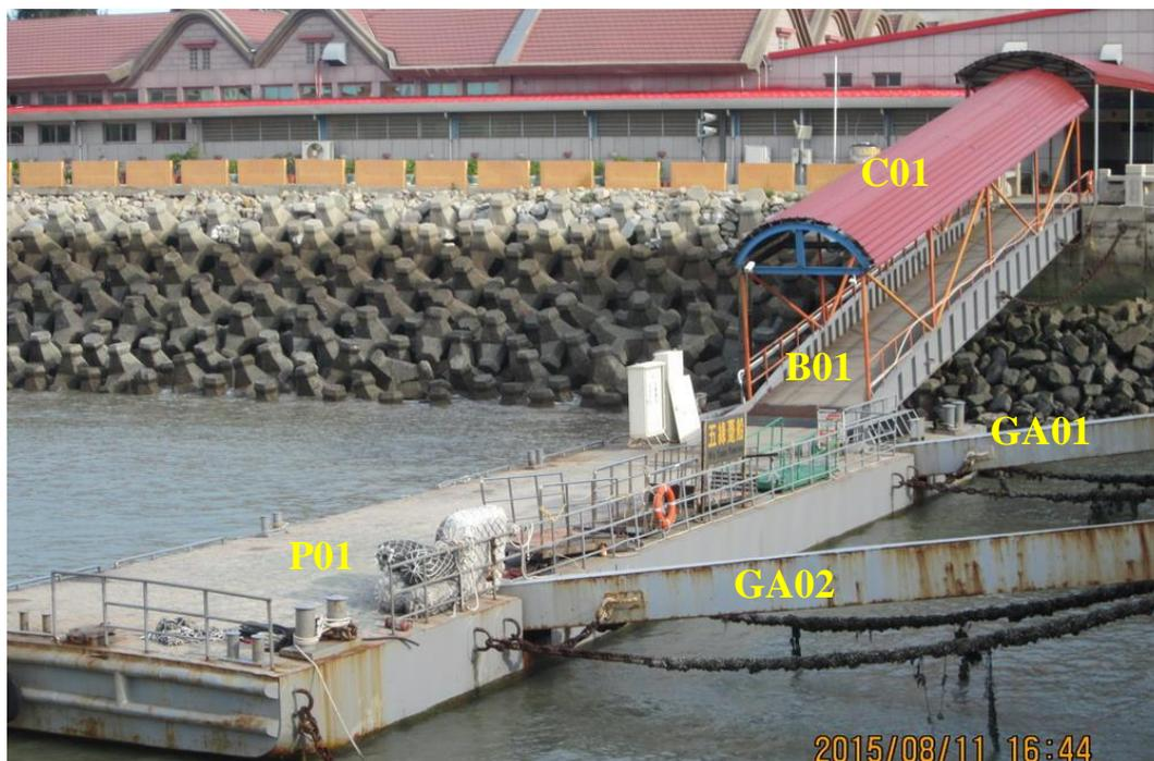
圖 4.23 水頭港區浮動碼頭五緣躉船整體構件編碼
