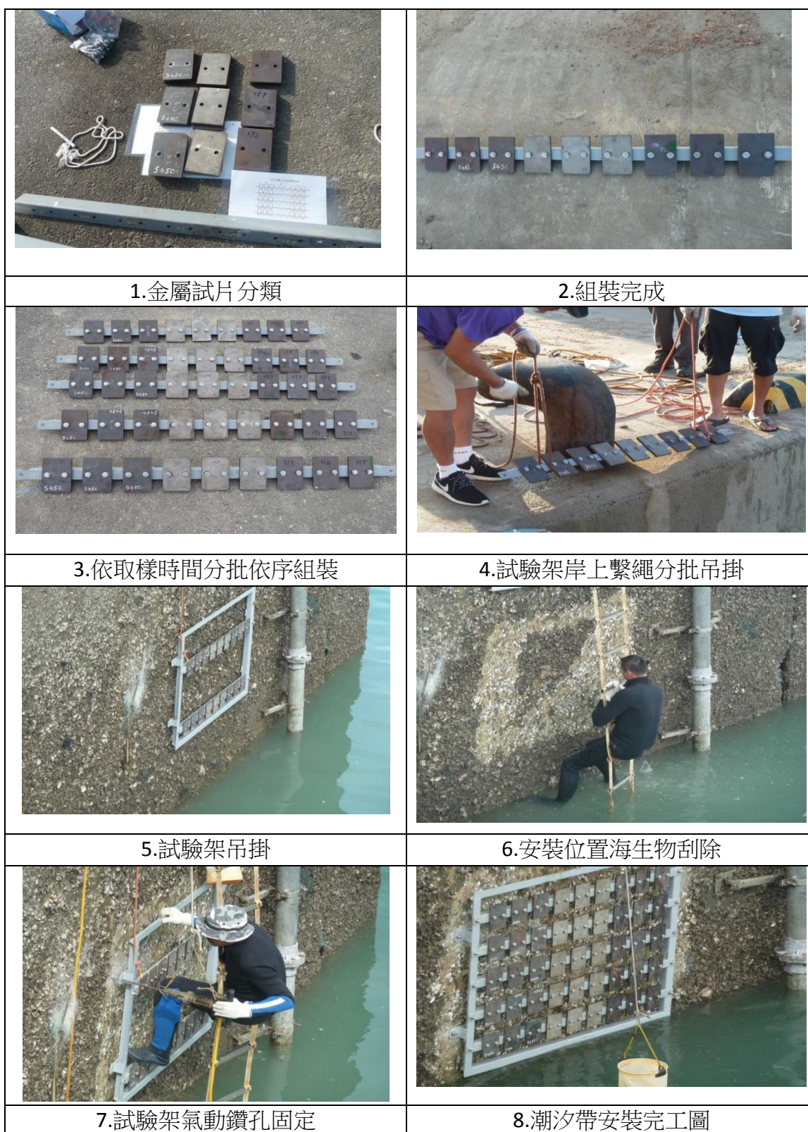
圖4.5 金門料羅港與水頭商港水下金屬曝露試驗架安裝
