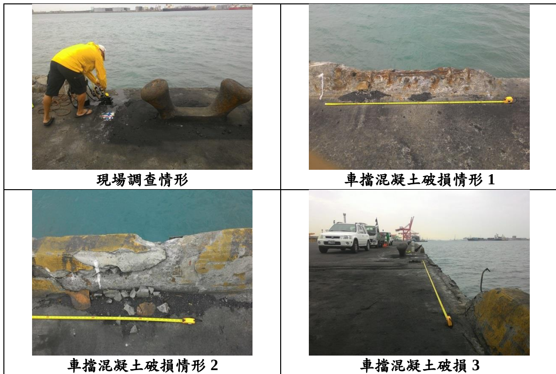
圖 5.129 臺中港 30 號碼頭岸上調查時現況(104.09、104.11)
