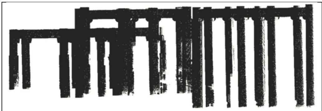
圖 5.85 九宮港區浮動碼頭基樁點雲圖
