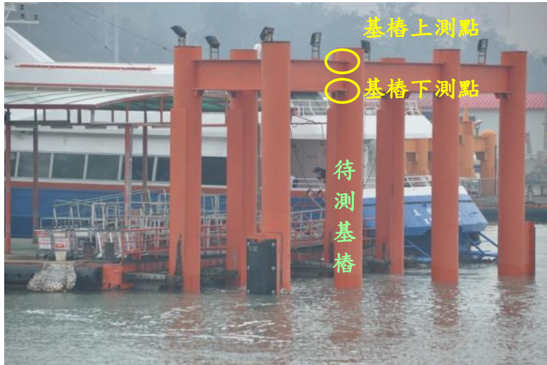
圖 5.61 基樁上、下視點設置原則
