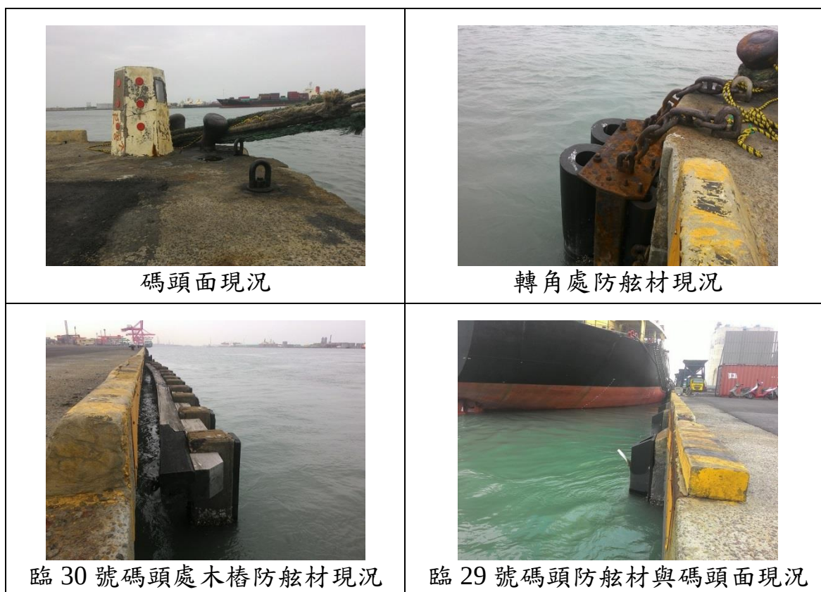
圖 5.127 臺中港 29 號碼頭角隅岸上調查時現況(104.09)
