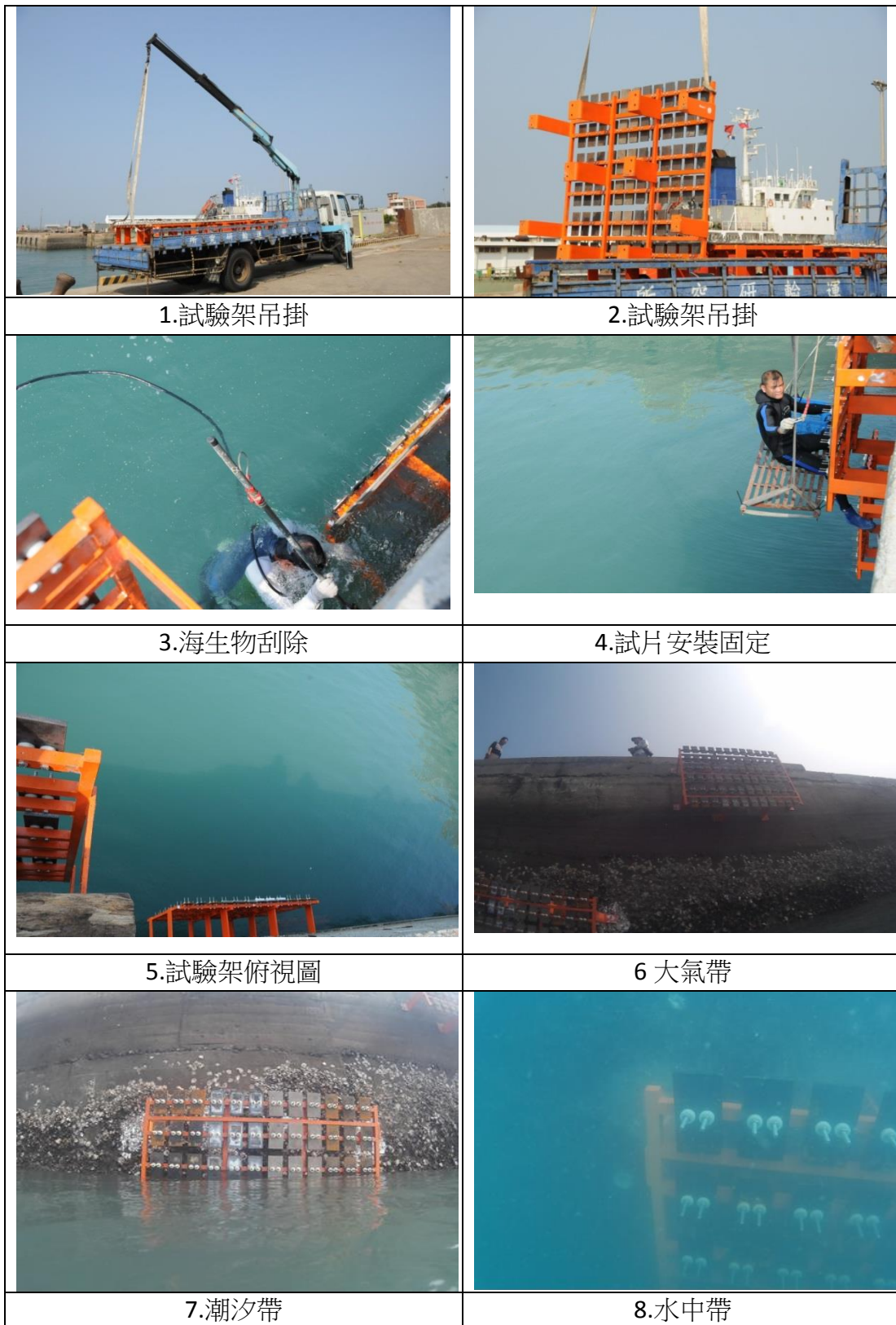
圖 4.3 臺中港水下金屬曝露試驗架安裝
