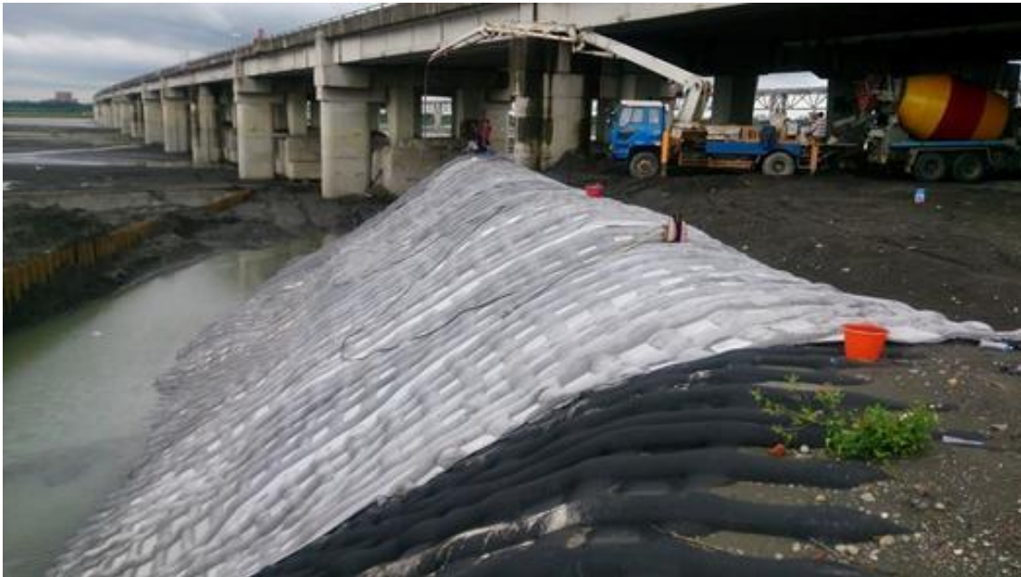
圖 7.1 砂腸袋配合織物模板保護工
