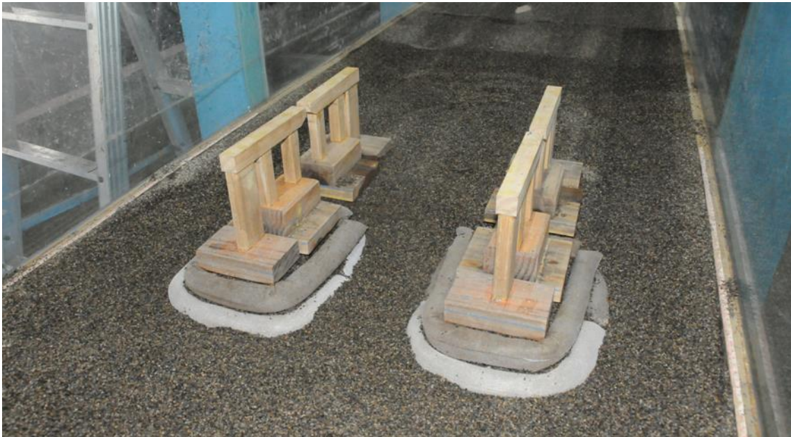
圖 7.36 二層斜坡砂腸袋鋪設
