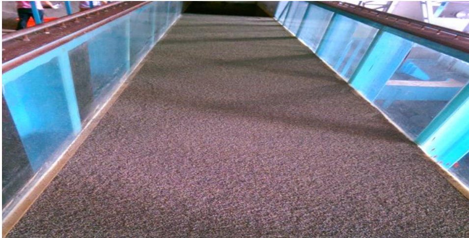
圖 7.4 底床鋪設情形
