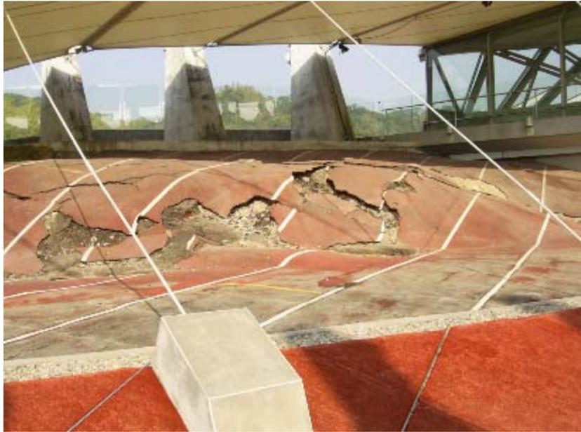
圖 5.7 1921 大地震造成地表斷層上下錯動
