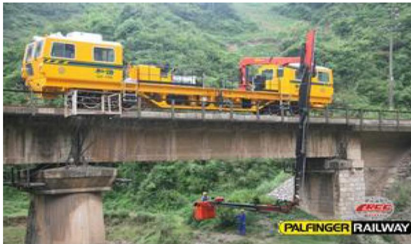
圖2.4 吊籃式橋梁檢測車
