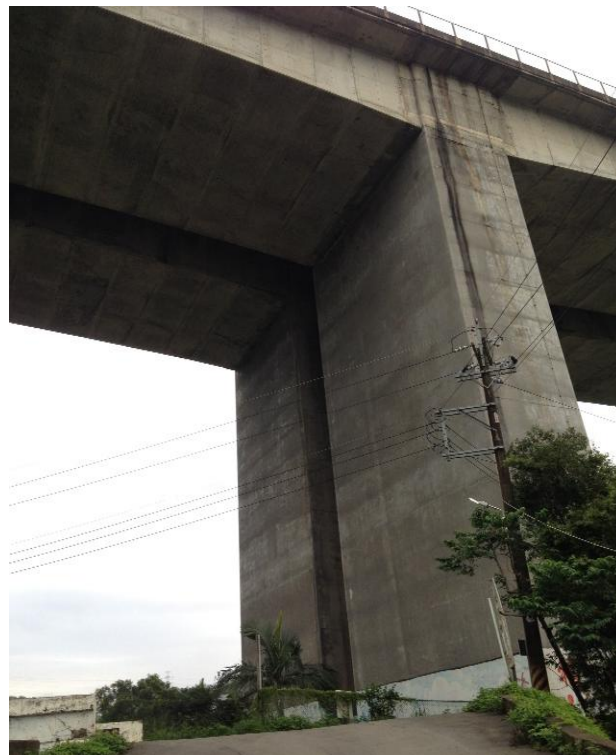
圖 5.4 牛欄河 2 號橋現況
