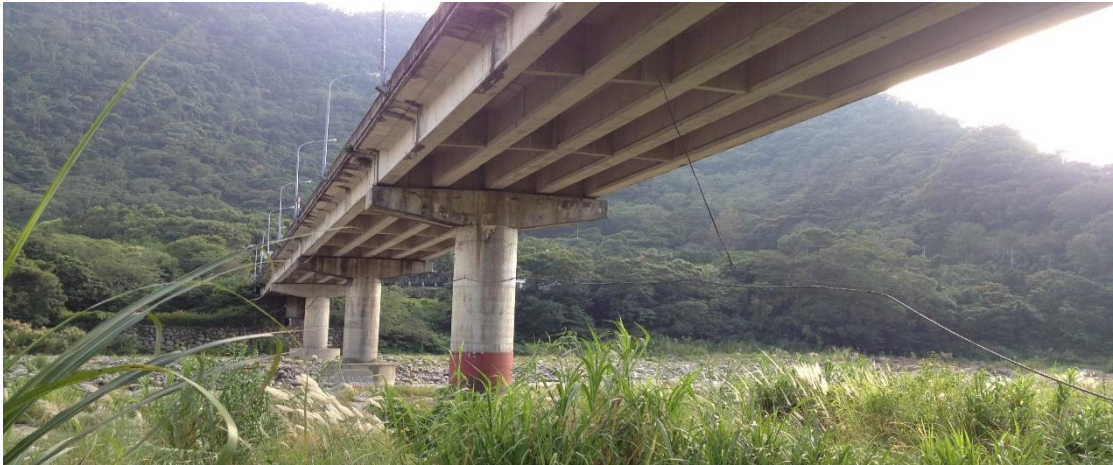
圖 5.5 內灣大橋現況
