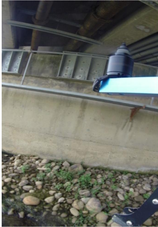
圖 5.15 O 型路線下拍攝之新大崛江橋橋墩照片
