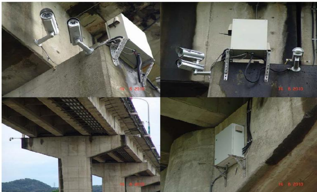
圖 2.16 新竹中正大橋與橋梁安全預警系統
