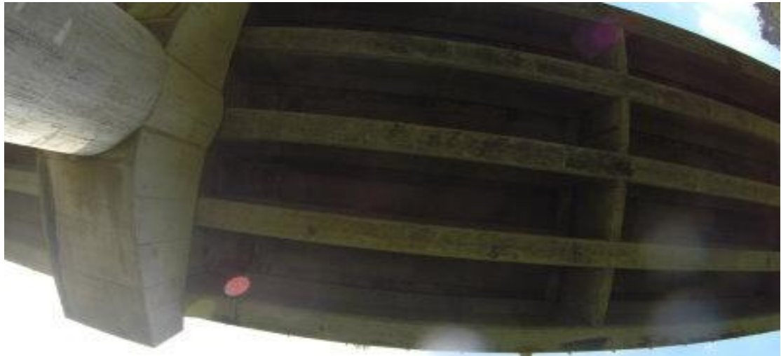
圖 5.18 半 S 型路線下拍攝之內灣大橋橋底照片
