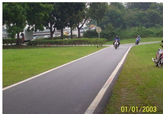
圖 S10.2 專用機車道
