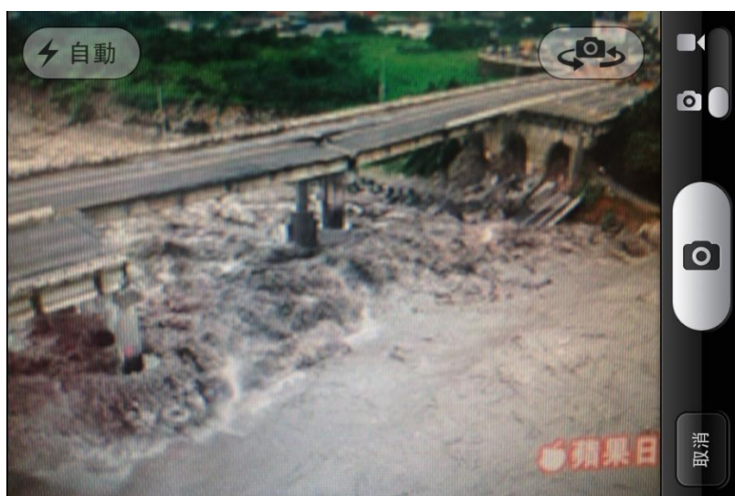
圖 5.6 開啟相機拍攝橋梁現況(以新聞歷史照片為例)
