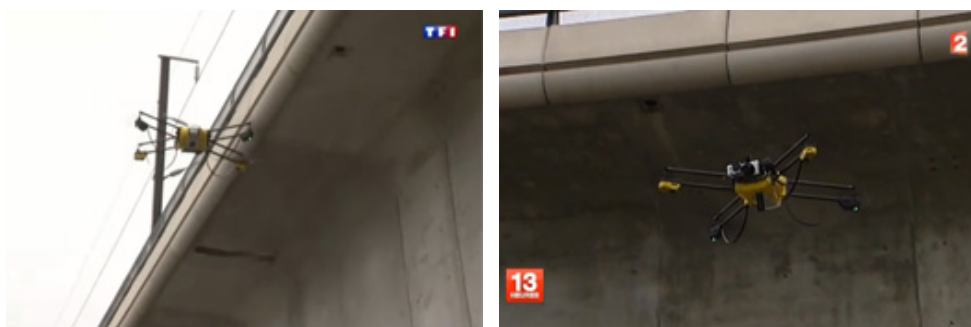
附圖 7.4 法國國營鐵路公司利用 UAV 進行鐵路橋樑結構檢視
