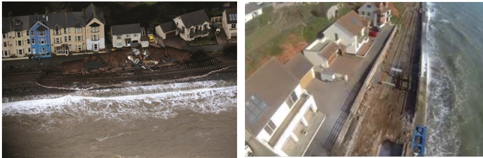
附圖 7.3 英國國營鐵路公司利用 UAV 協助鐵路勘災及重建
