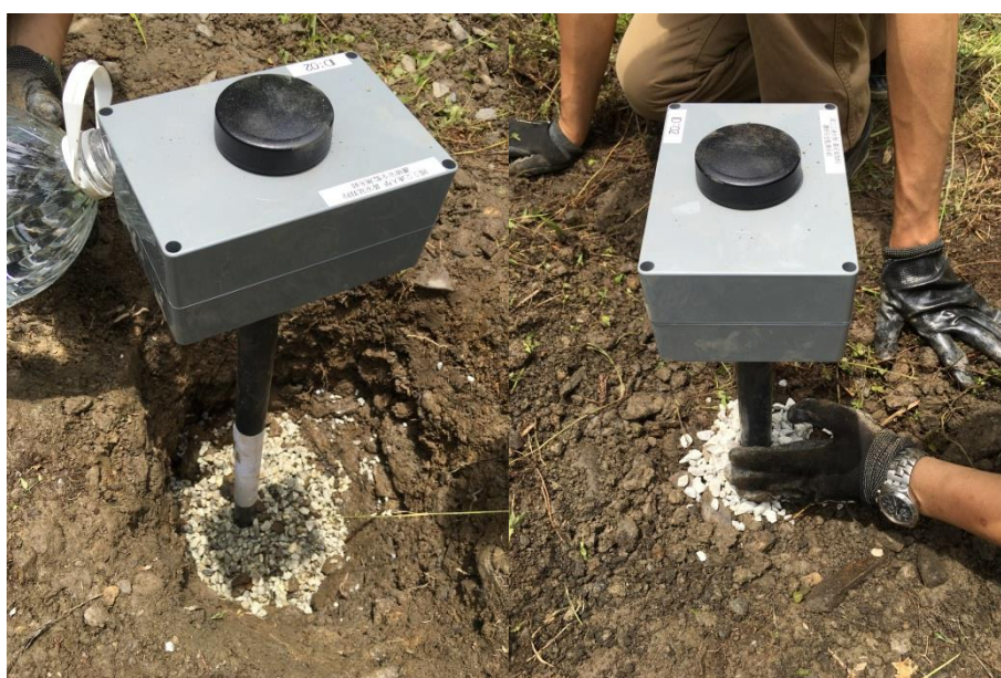
圖 4.26 阻水層回填照片
