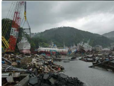
日本氣仙沼港灣破壞
