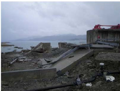
日本高田市防波堤破壞
