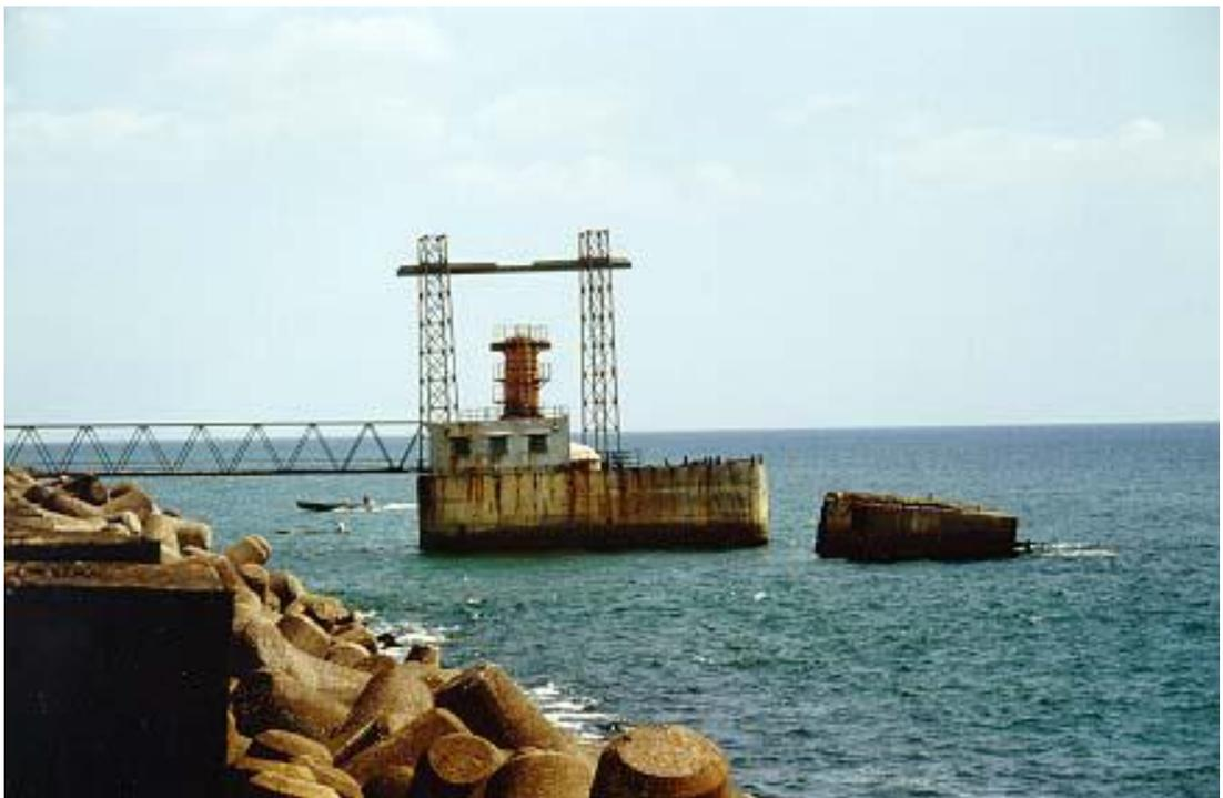
圖 2.18 Vizhinjam OWC 沉箱前防波堤結構
