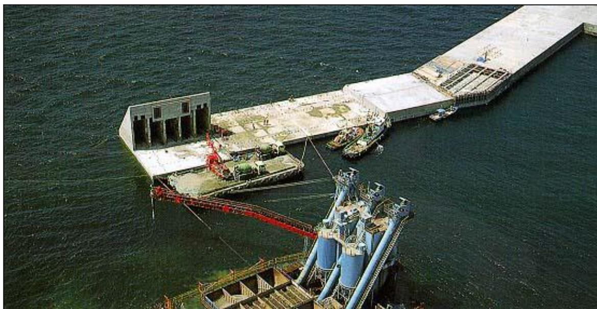
圖 2.23 Sakata OWC 的沉箱施工階段
