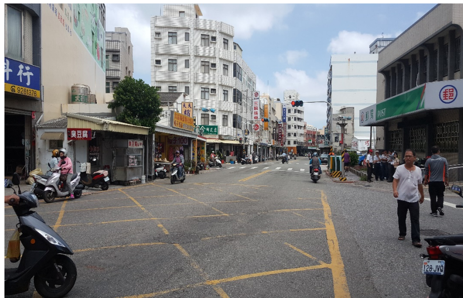
編號 102 澎湖縣縣道 203 線與都市計畫 20-3 號道岔路口
