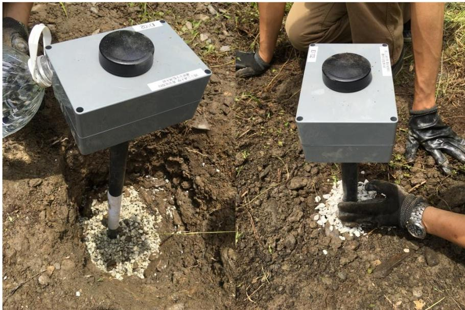
圖 3.26 阻水層回填照片
