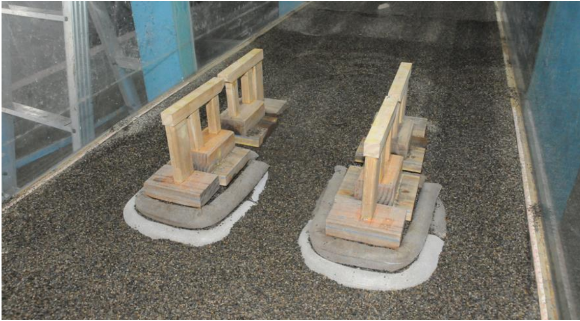
圖 6.36 二層斜坡砂腸袋鋪設
