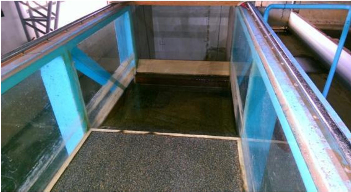
圖 5.6 渠槽尾水控制閘門
