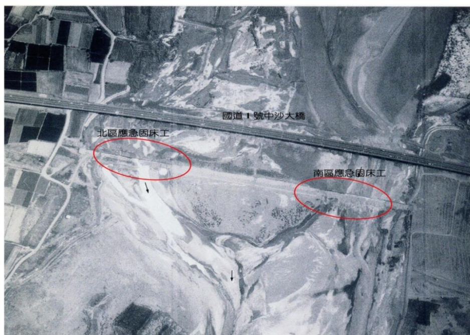
圖 3.3 中沙大橋下游固床工
