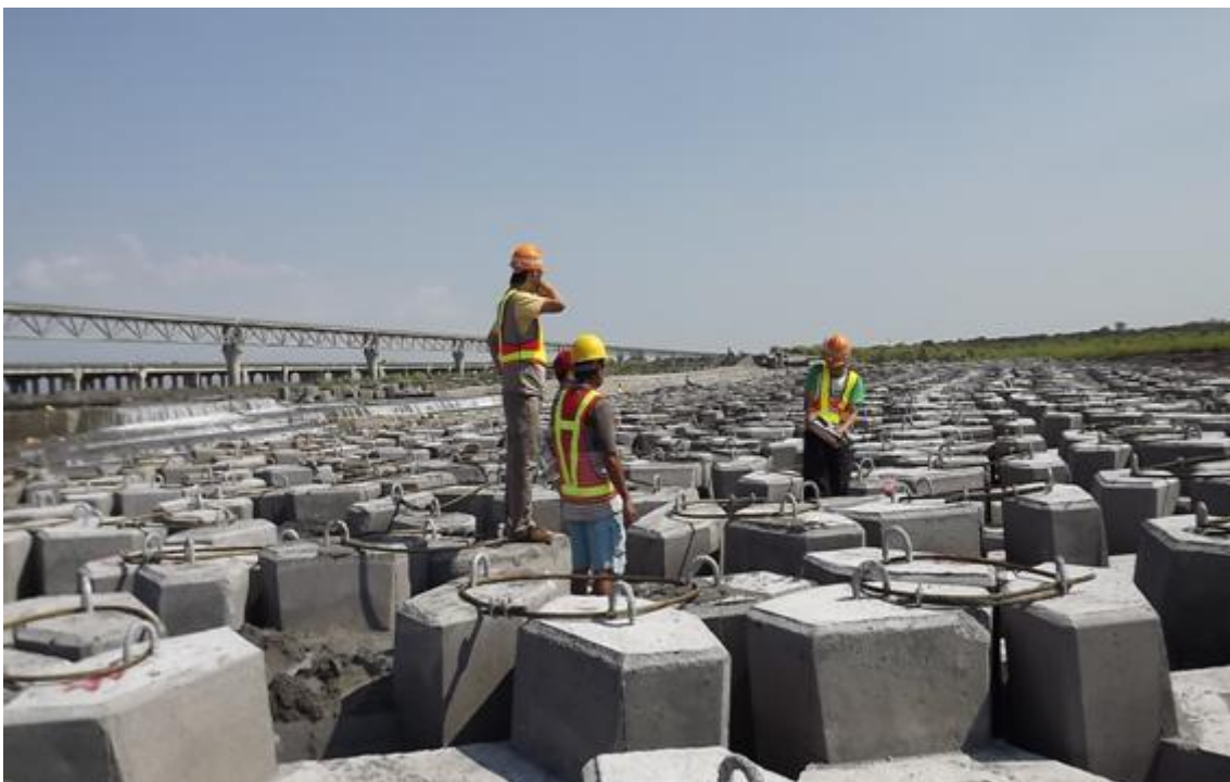
圖 5.4 中工處加長潛堰護坦消能工施作情形
