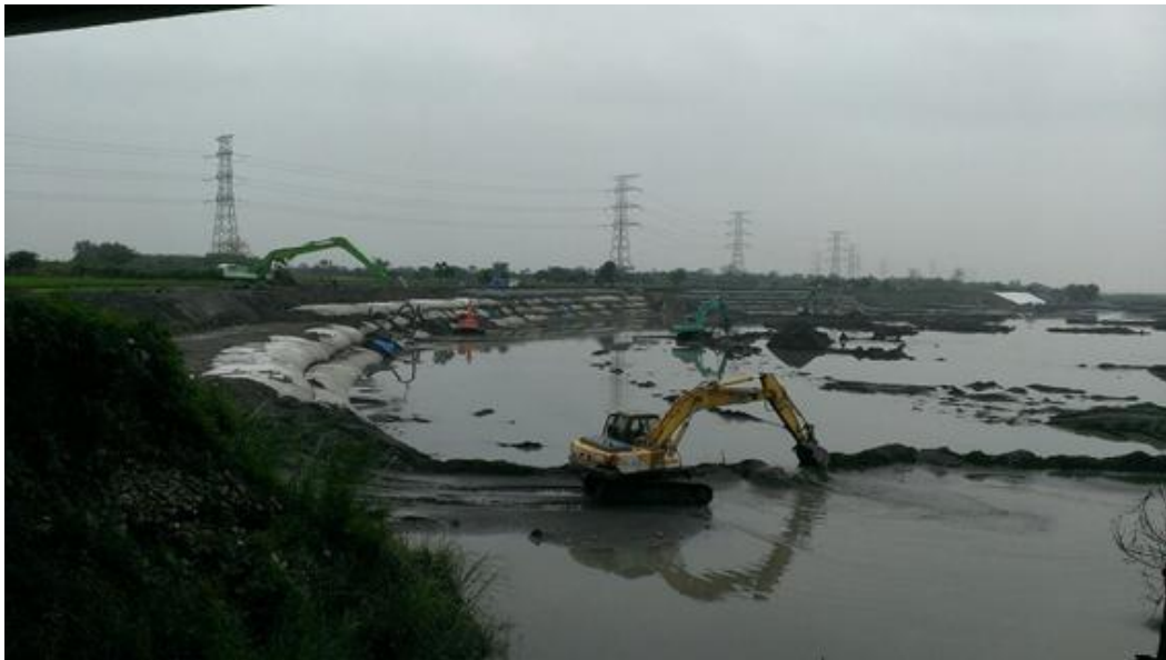
圖 5.1 四河局於中沙大橋上游高灘地之保護工施作情形
