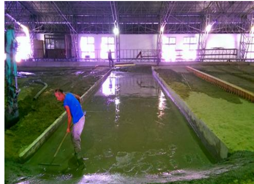
照片7.8 沉砂池製作
