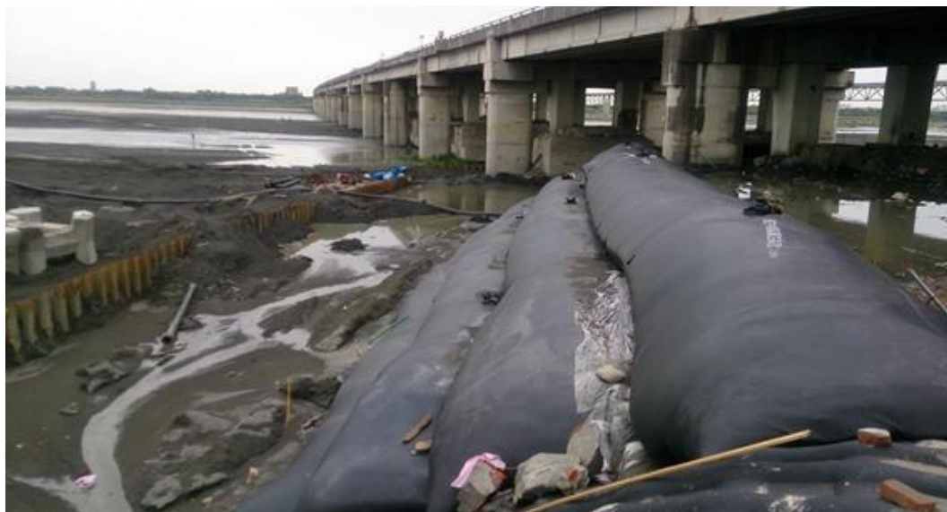
圖 5.2 中工處於中沙大橋橋基高灘地之砂腸袋施作情形
