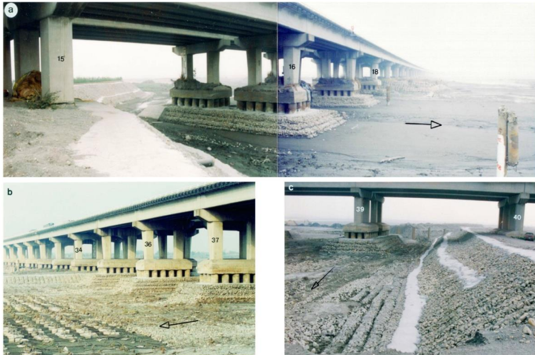
圖 3.2 中沙大橋橋墩保護工
