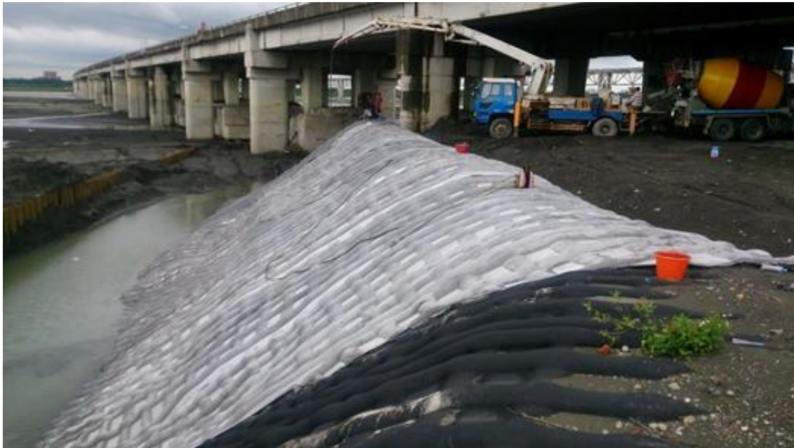
圖 6.1 砂腸袋配合織物模板保護工
