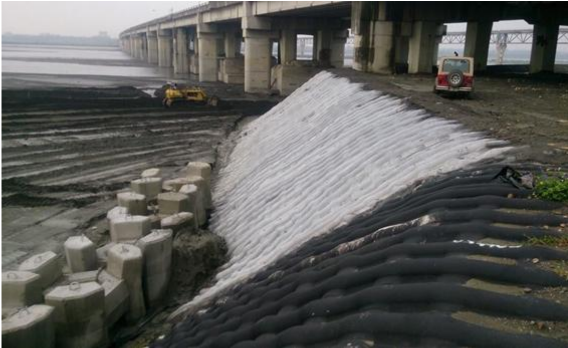
圖 5.3 中工處於中沙大橋橋基高灘地之織物模板施作情形
