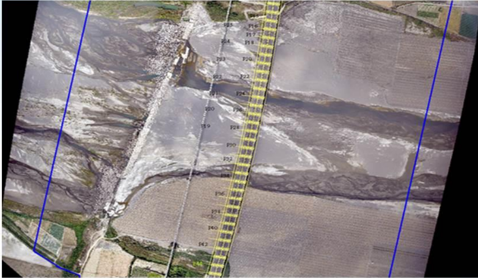
中沙大橋上、下游500公尺範圍之正射影像圖
