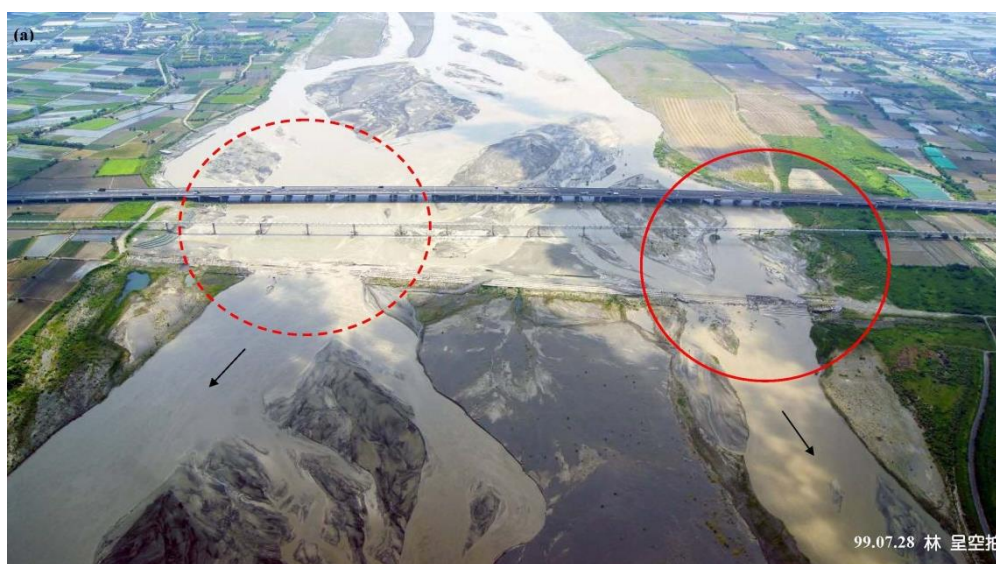
圖 3.6 中沙大橋上游及兩岸高灘地沖刷狀況
