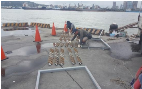
金屬腐蝕試驗架安裝
