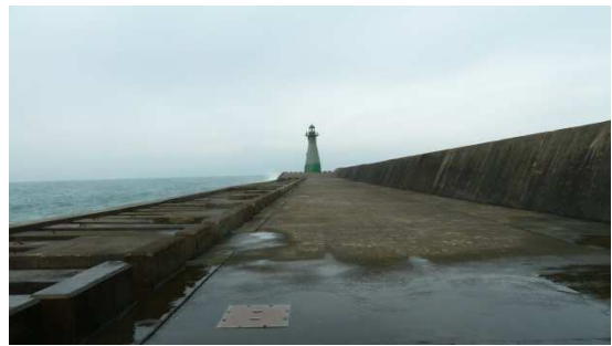
延長段堤面混凝土現況-6
