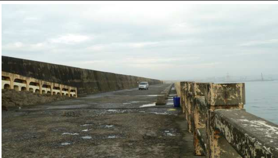
堤面混凝土現況
