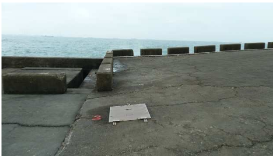
延長段堤面混凝土現況-7
