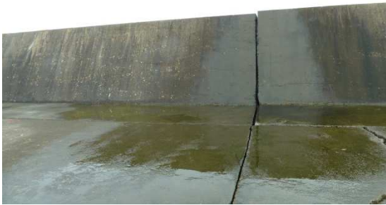
延長段堤面混凝土現況-5
