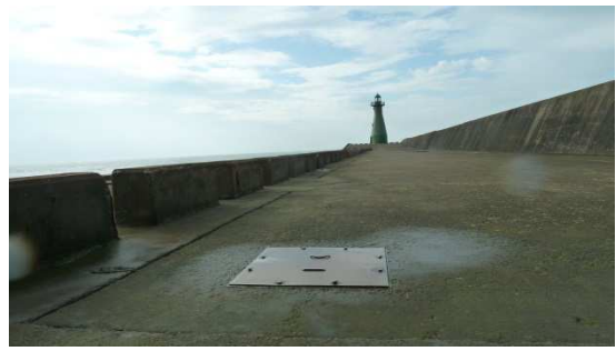
延長段堤面混凝土現況-2
