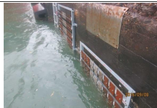
高雄港#40 試驗架安裝完成
