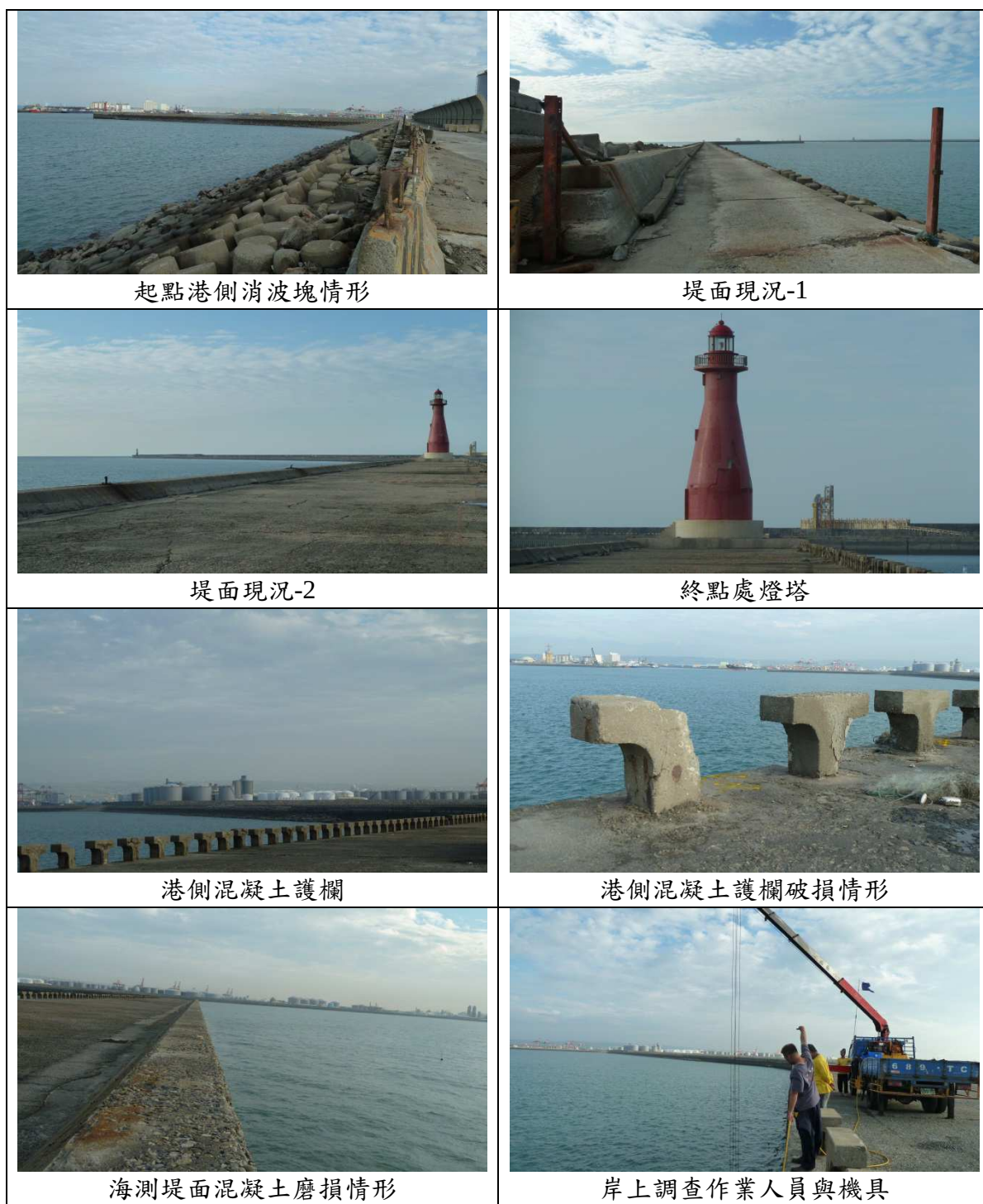
圖 5.60 臺中港南防波堤現況調查情形(105.11)
