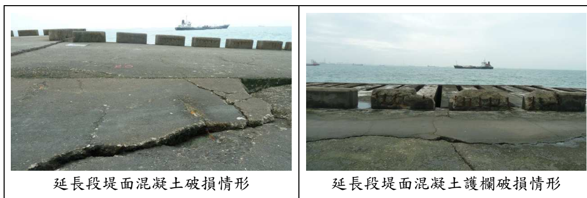
圖 5.63 臺中港北防波堤岸上調查時現況(105.11)
