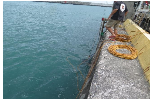
潛水員清除岸壁面海附生物
