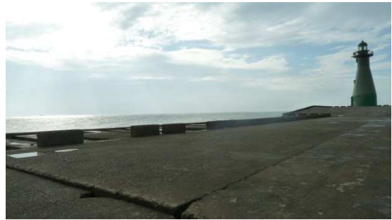
延長段堤面混凝土現況-4
