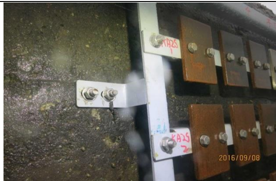
飛沫帶試驗架組裝完成
