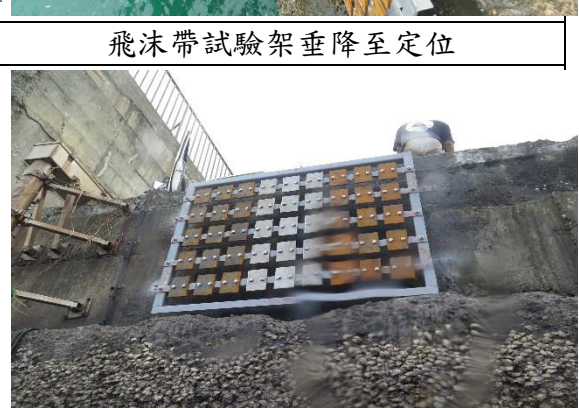
花蓮港試驗架安裝完成
