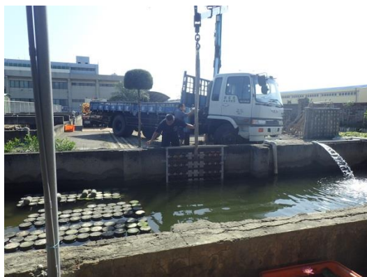
試驗架組裝完成
