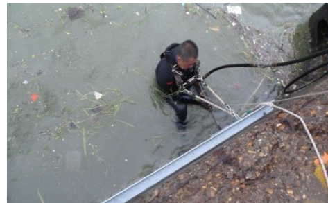
水下帶試驗架安裝完成
