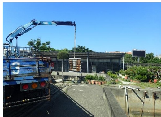
金屬腐蝕試驗架吊掛
