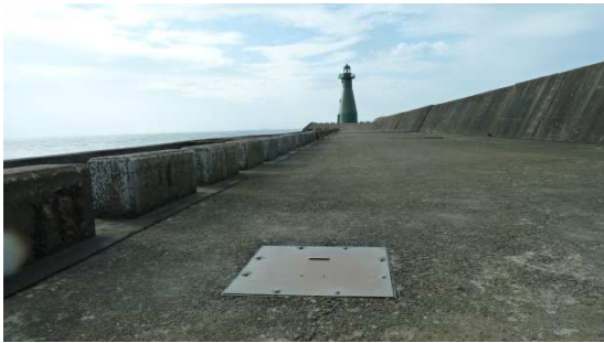
延長段堤面混凝土現況-3
