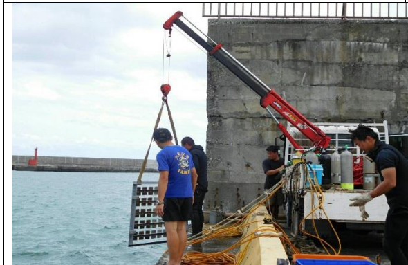
車用吊桿吊放金屬腐蝕試驗架
