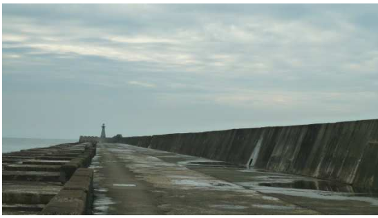
延長段堤面混凝土現況-1
