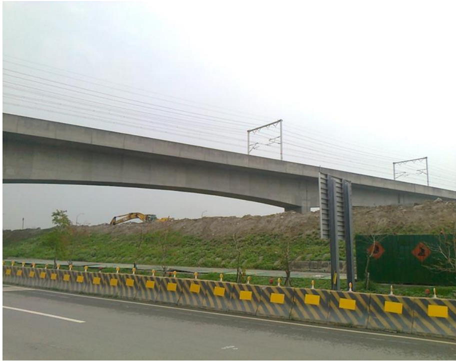
圖 4.7 高鐵與台 78 號道路跨交處路堤移除中(港研中心，2014.04)
