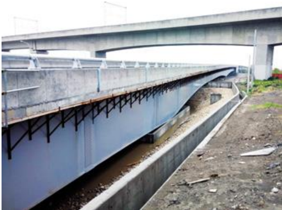
圖 4.8 高鐵與台 78 號道路跨交處改高架橋(高鐵局，2015.06)
