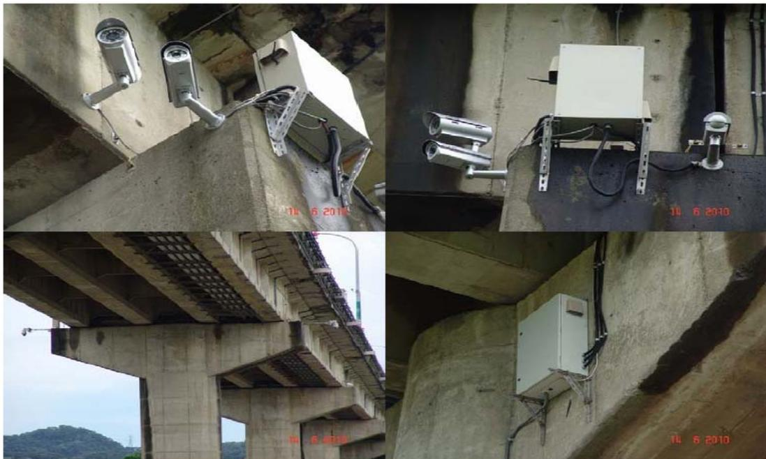
圖 2.16 新竹中正大橋與橋梁安全預警系統
