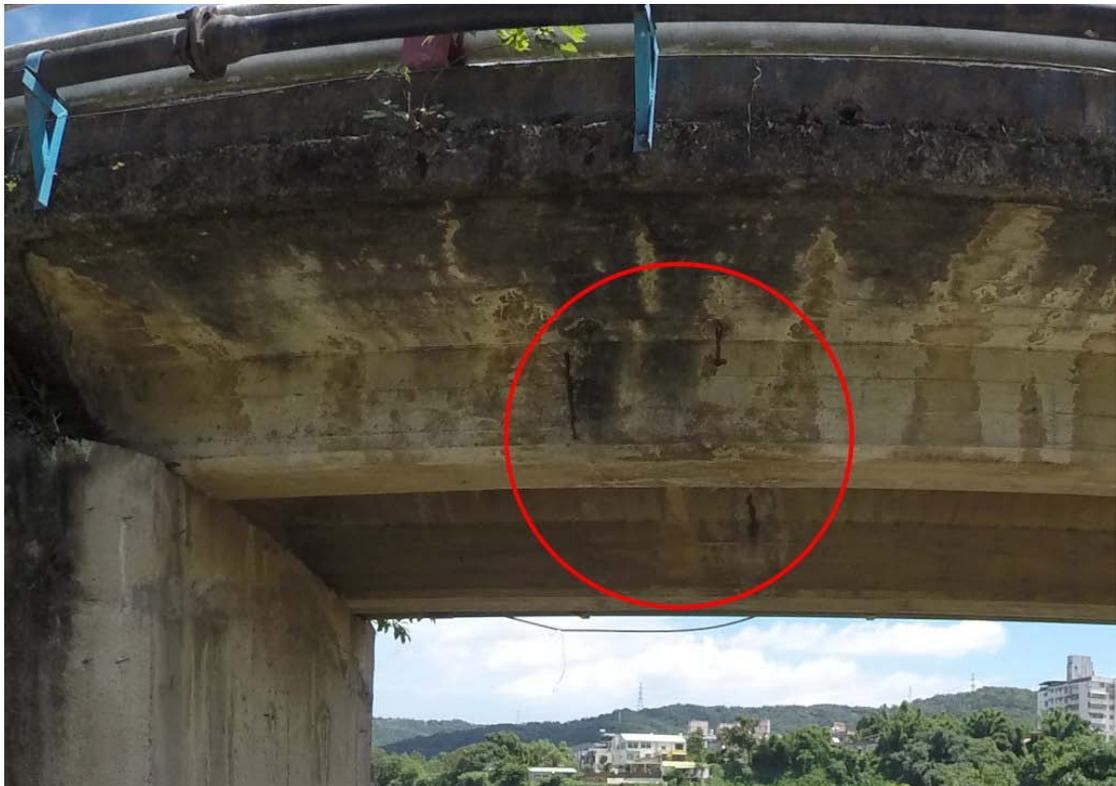
圖 5.7 南山大橋第六橋孔鋼筋外露
