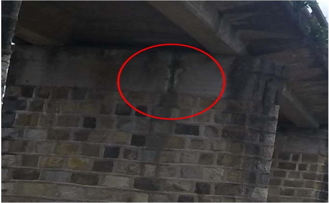
圖 5.8 南山大橋第四墩鋼筋外露照片
