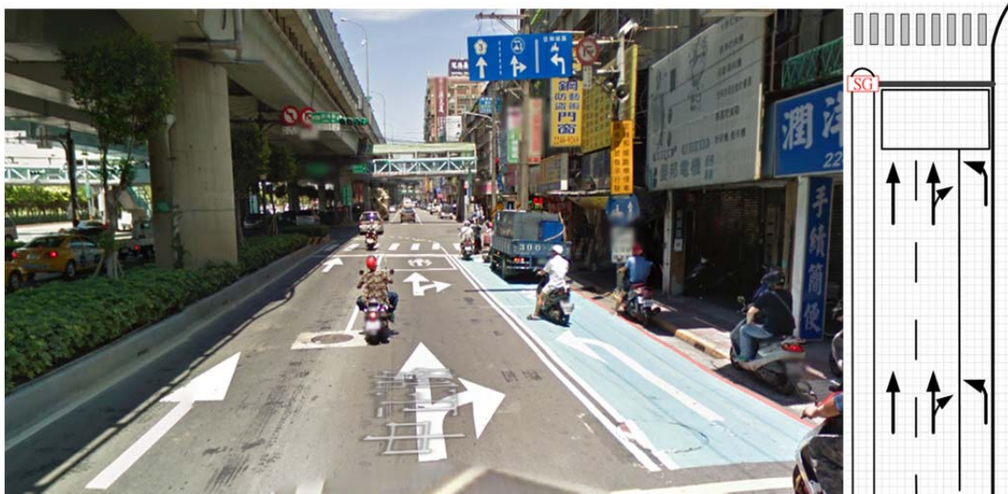
圖 7. 機車左轉專用道設置於外側車道
