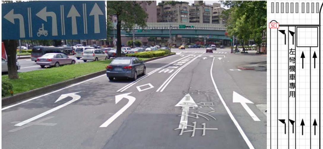
圖 5. 機車左轉專用道設置於內側車道
