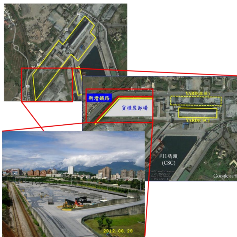
圖 5 中鋼花蓮石料場運輸模式改變專案計畫場址 [6]
