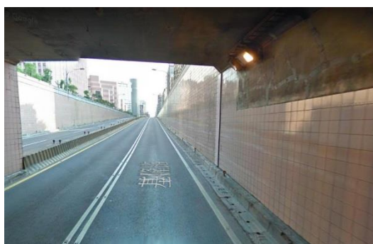
圖 10.1 臺北市信義區基隆路地下道之車道配置（2 快車道/禁行機車）
