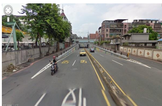
圖 10.3 新北市板橋區大觀路地下道之車道配置（1 快車道、1 混合車道）
